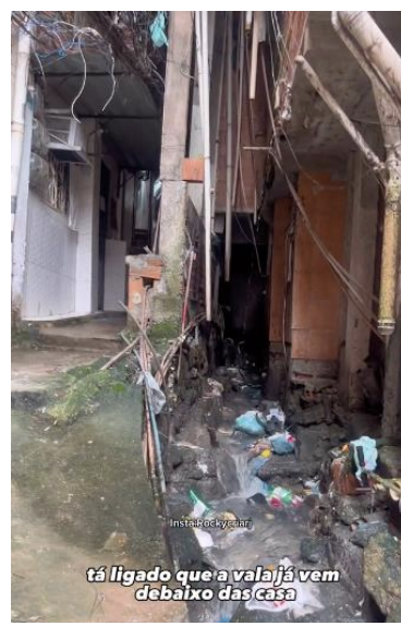
Figura 41 "a vala já vem debaixo das casa" (sic). O esgoto das moradias fica exposto próximo aos passeios. Rock Cria (2023)
