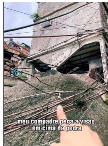
Figura 39 Fundação da casa feita diretamente na pedra. Rock Cria (2023)
