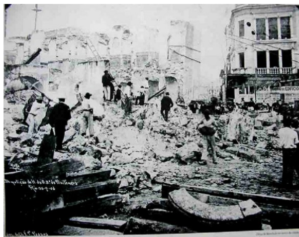
Figura 4. Demolição de cortiços no centro da cidade. (Malta, 1903).
