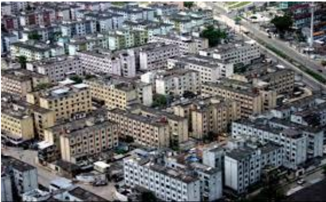
Figura 24 Conjunto Residencial Cardeal Dom Jaime de Câmara, construído em 1969 na Zona Oeste, conta com 7000 habitações (Chelsea, 2010).
