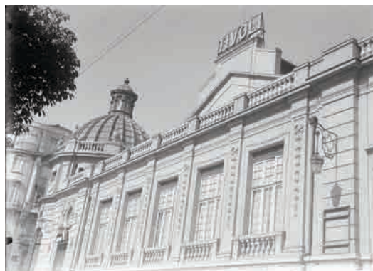
Fig. 5 - Exterior do Cinema Tivoli, (n.d.)
