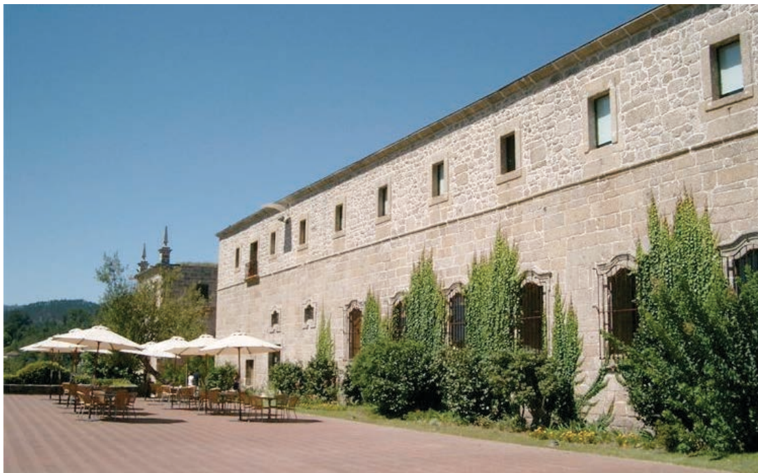
Fig. 23 - Fachada Sul da Pousada, 2006
