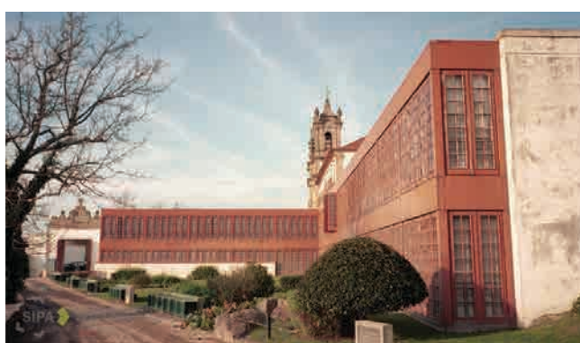
Fig. 22 - Fachada lateral, do novo volume, 1993
