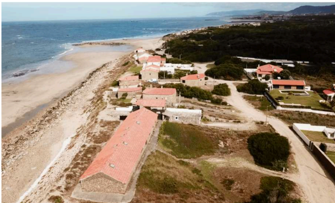
Figura 27 - Abrigos dos pescadores reabilitados para habitações secundárias
