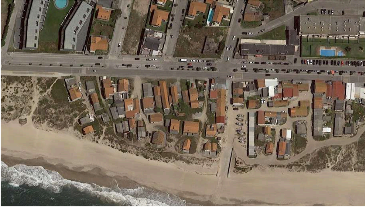
Figura 20 - Vista aérea dos barracos
