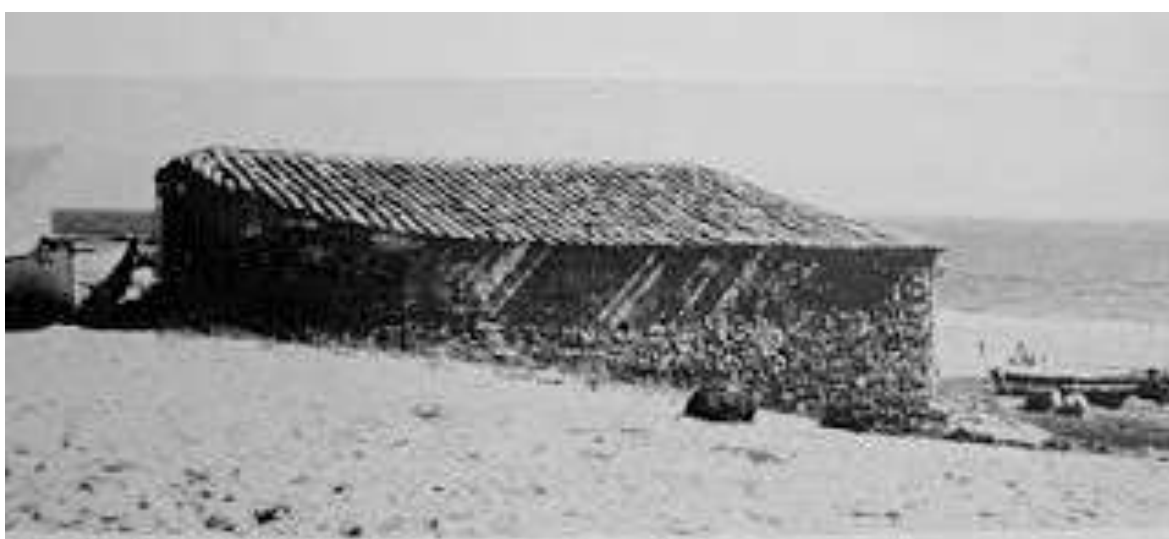
Figura 24 - Barraco de planta arredondada, 1962
