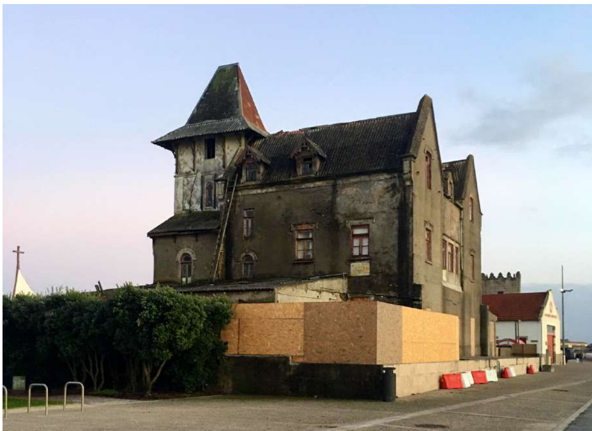
Figura 45 - Fachada do edifício, 2021
