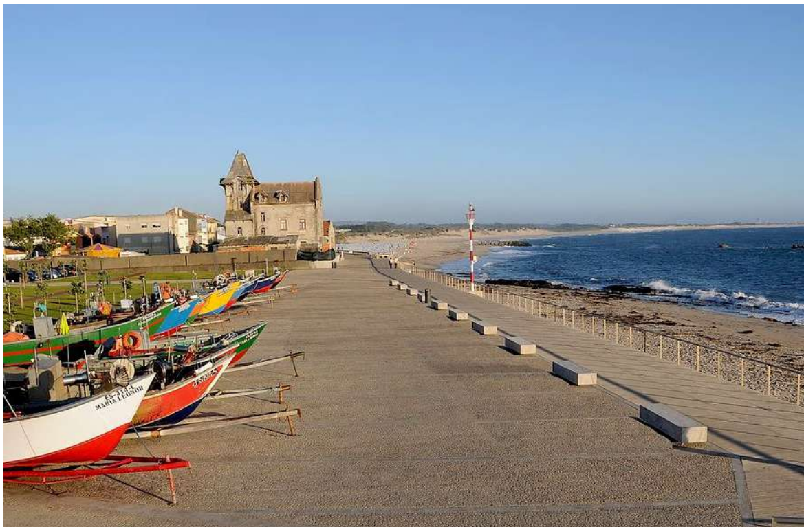
Figura 41 - Edifício Pérola do Atlântico localizado na marginal da Vila de Apúlia
