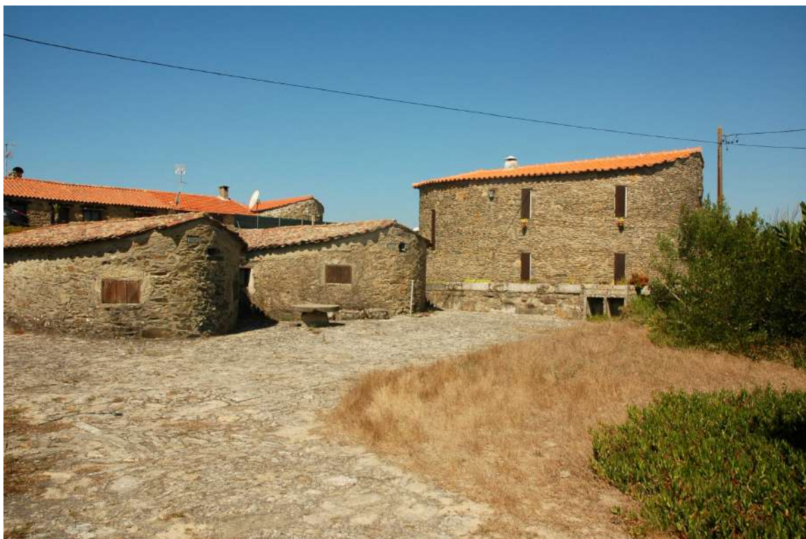
Figura 28 - Abrigos dos pescadores reabilitados para habitações secundárias
