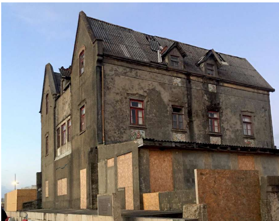
Figura 44 - Edifício Pérola do Atlântico, 2021
