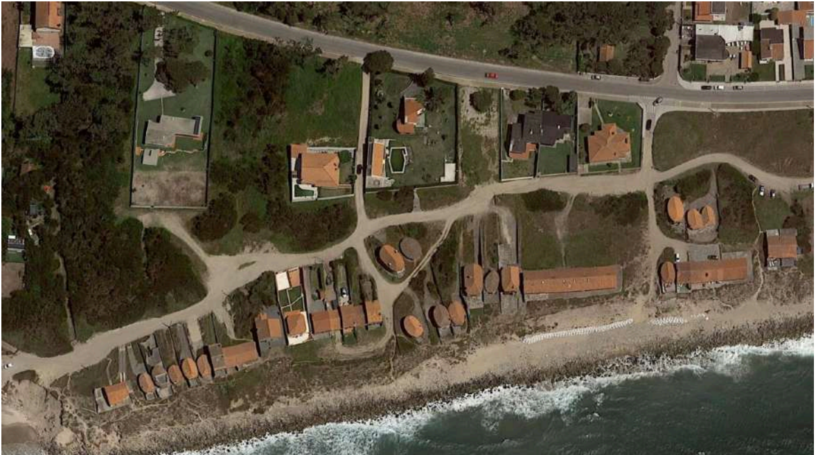
Figura 21 - Vista aérea dos barracos
