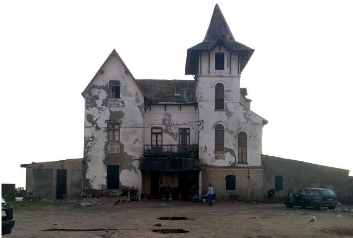
Figura 47 - Fachada do edifício, 2021
