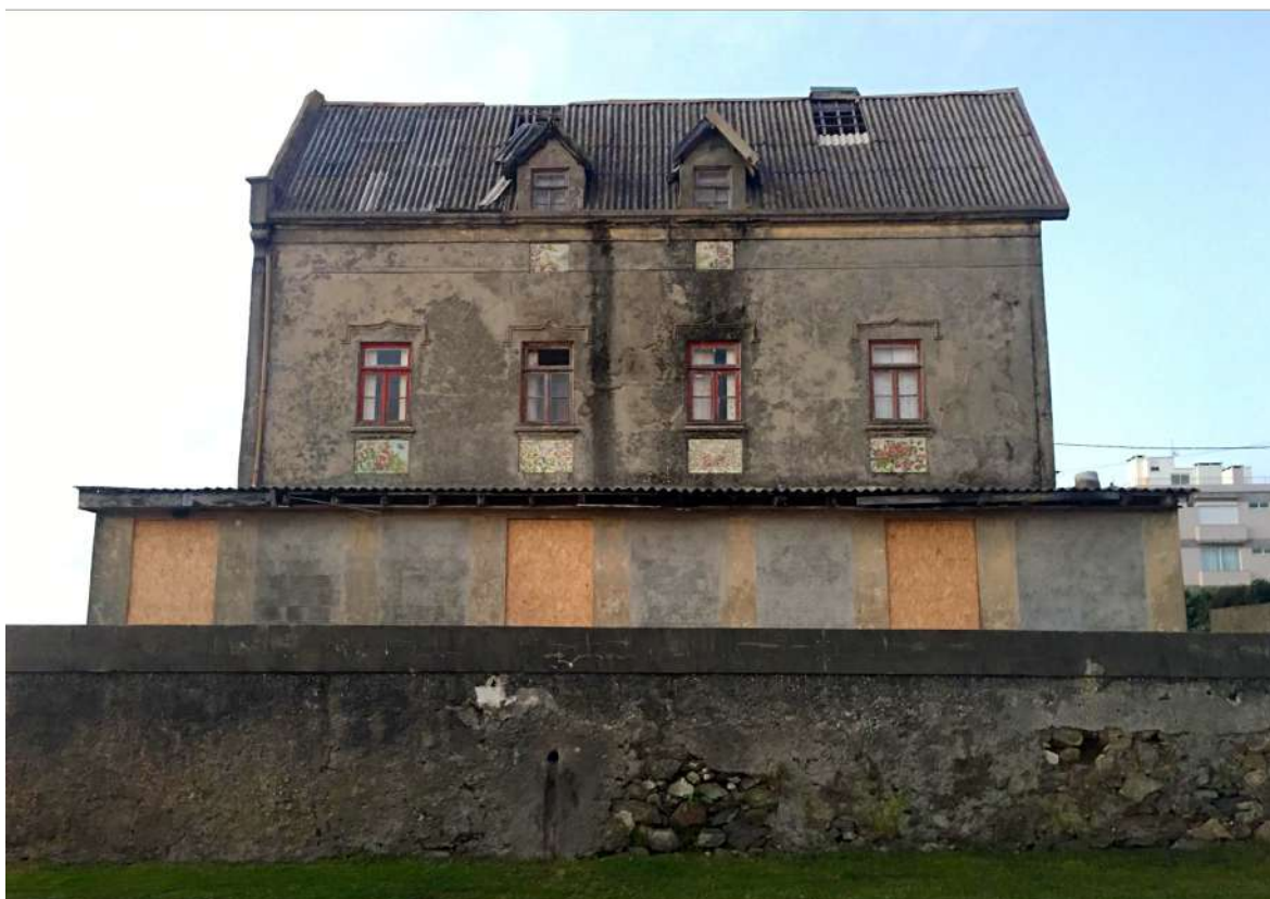
Figura 46 - Fachada do edifício, 2021
