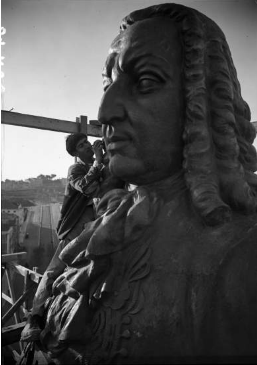
Figura 46 - Trabalhador na estátua do Marquês de Pombal. 1931. Fotografia de Ferreira da Cunha. “O Notícias Ilustrado” II Série, 296. Arquivo municipal de Lisboa
