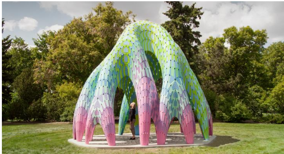
Figura 2.5 - "Vaulted Willow" Canadá. Marc Fornes (TheVeryMany) para The Edmonton Arts Council, 2014 - A estrutura é composta por 721 elementos de alumínio conectados por 14,043 rebites (Contemporist, 2015)
