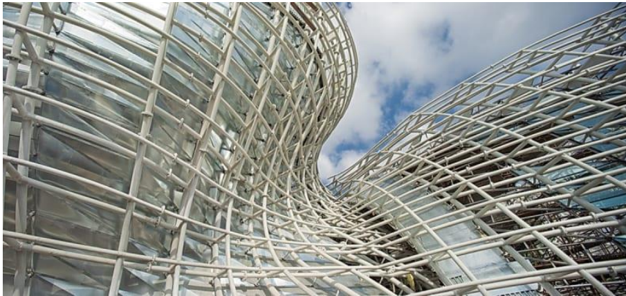
Figura 1.31 – Estrutura do Pavilhão espanhol para a Expo Shangai 2010. Criado pela firma de arquitectura EMBT em parceria com a (divisare, 2010)
