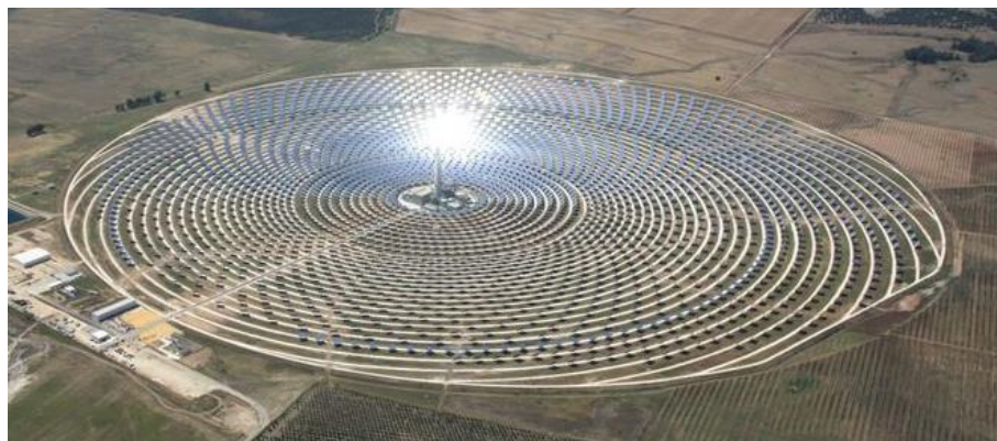
Figura 1.77 – Gemasolar, central fotoelétrica, Andaluzia, Espanha (asknature.org, 2017).
