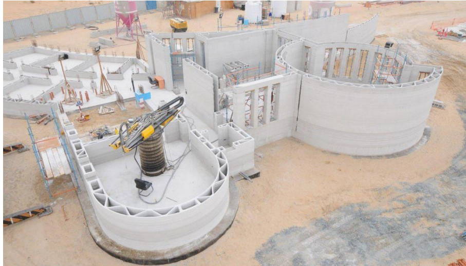
Figura 2.25 – Edifício construído por fabricação aditiva com recurso a um braço robótico no Dubai pela empresa Apis Cor (Block, 2019)
