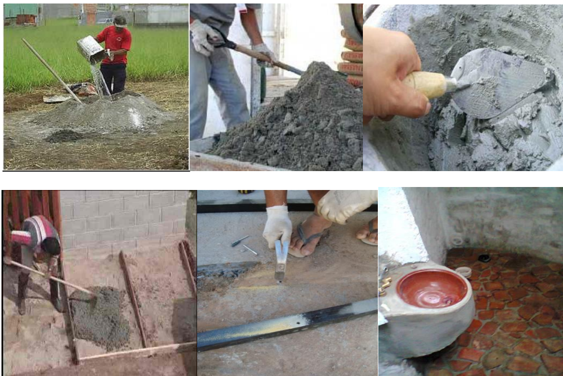
Fig. 4.37 - Construção de um lavatório com areia e cimento. Fonte: (Fazer facil, reforma e construção s.d.)
