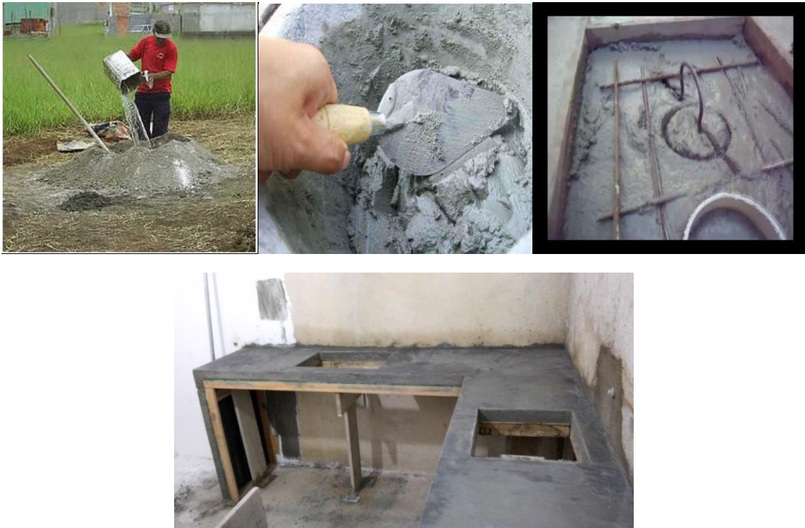
Fig. 4.38 - Construção de uma bancada com areia e cimento. Fonte: (Fazer facil, reforma e construção s.d.)
