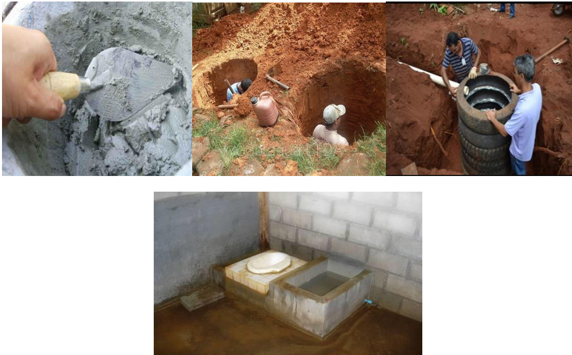
Fig. 4.36 - Construção de uma sanita com cimento e areia Fonte: (Obvious s.d.)
