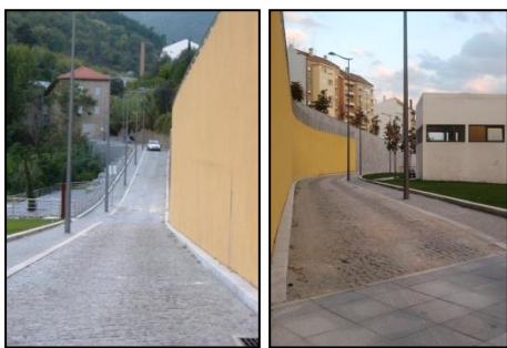
Figura 120. Caminho do Biribau, acesso à Universidade da Beira Interior _____
