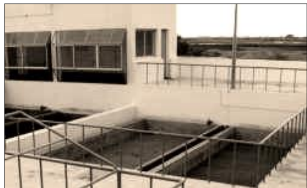
Figura 9. Filtro de areia em Estação de Tratamento de Águas
