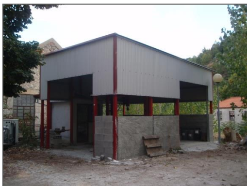
Figura 149. Espaço existente de arrecadação _
