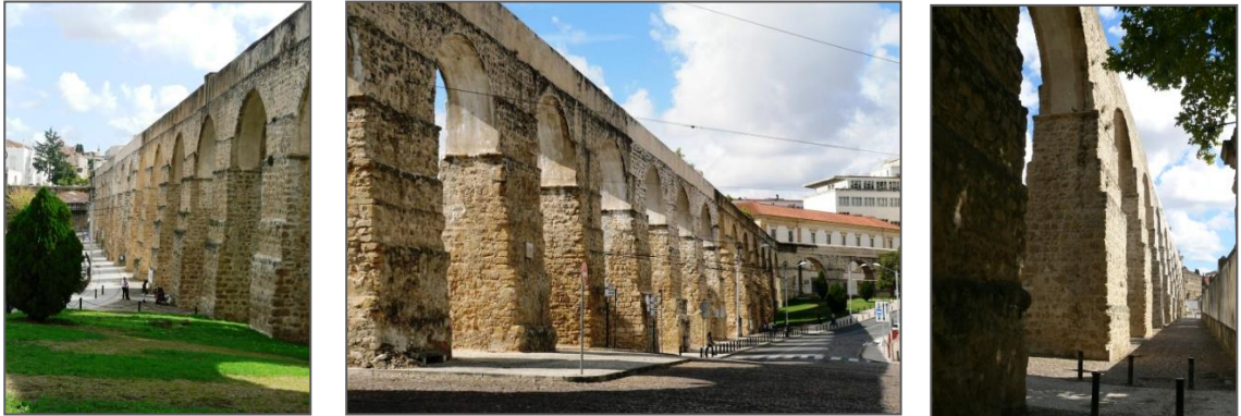
Figura 69. Perspectivas fotográficas do Aqueduto S. Sebastião em Coimbra
