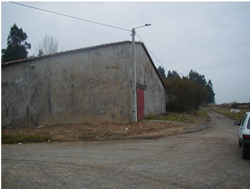
Figura 5.1.1 – Fotografia dos primórdios do edifício (Fonte própria)
