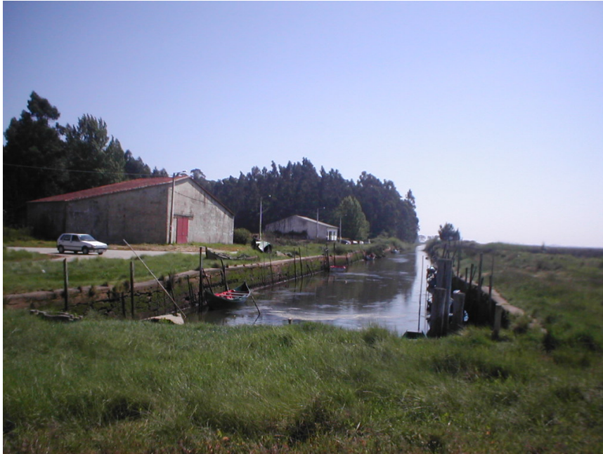
Figura 5.1.2 – Fotografia do edifício face ao cais (Fonte própria)
