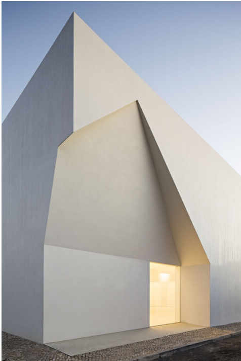
Figura 4.4.1 – Fotografia da fachada (Fonte_27)
