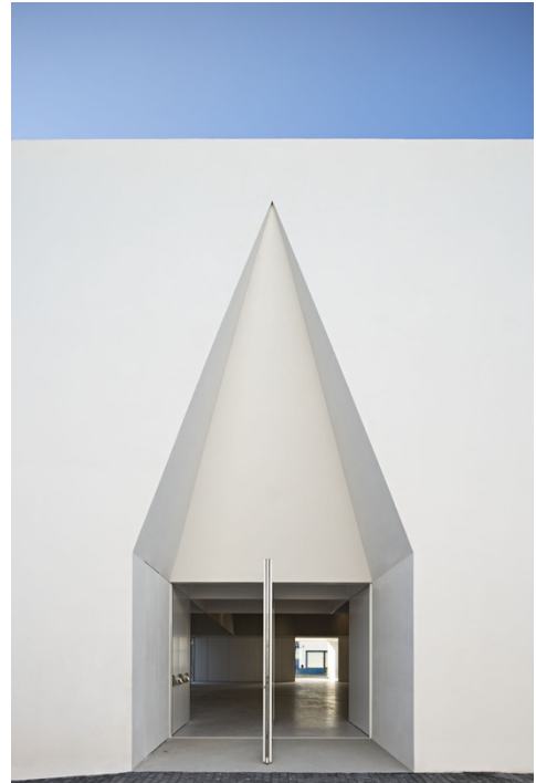
Figura 4.4.2 – Fotografia da Fachada (Fonte_28)
