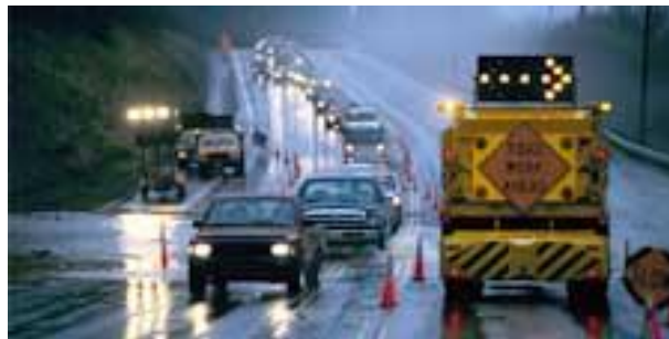
Figura 3.1 - Trânsito numa zona de trabalho [50]
