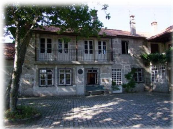
Figura 8: Fachada Interior da FAR. Fonte: Ana Albuquerque
