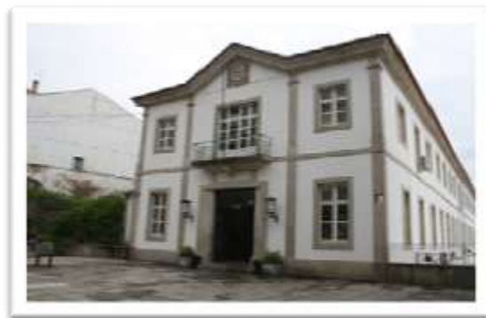
Fig.2 - Fachada principal da Escola
