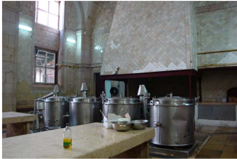
Imagem 29: Cozinha do Convento (utilizada actualmente pela EPI), Maio 2009 (foto de autor)
