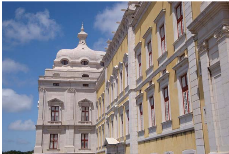
Imagem 17: Pormenor da fachada principal, Maio 2009 (foto de autor)
