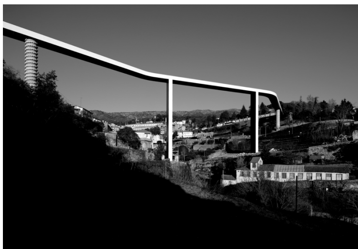
Figura 29- Ponte da Carpinteira, Covilhã, projeto de Carrilho da Graça, 2009
