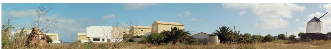
Fig.19 Moinho em mau estado, à esquerda, e moinho giratório reconstruído à direita
