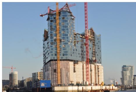
Figura 30 – Vista do edifício em construção.
