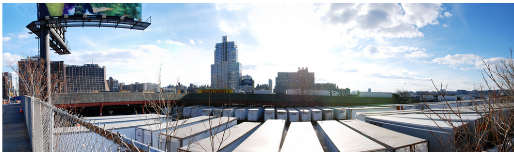
Figura 32 – Vista do terreno, a Este.
