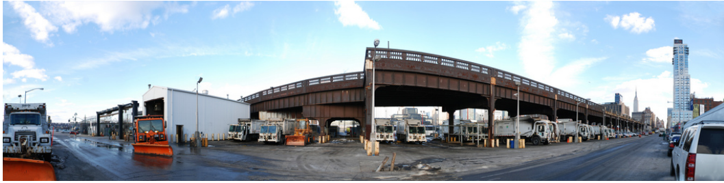
Figura 10 – Vista do terreno da rua 30th (Sul).
