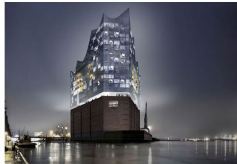
Figura 27 – Aspecto exterior, quando concluído.
