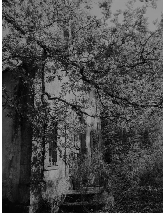
Figura 48. Capela existente no local de intervenção
