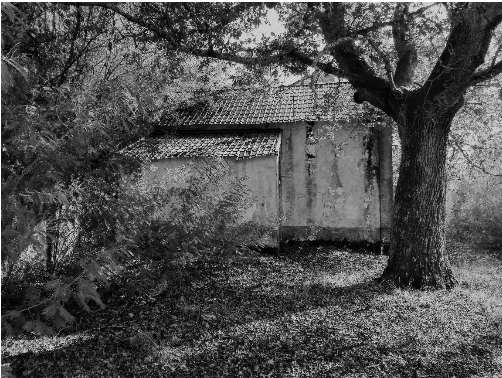
Figura 49. Capela existente no local de intervenção
