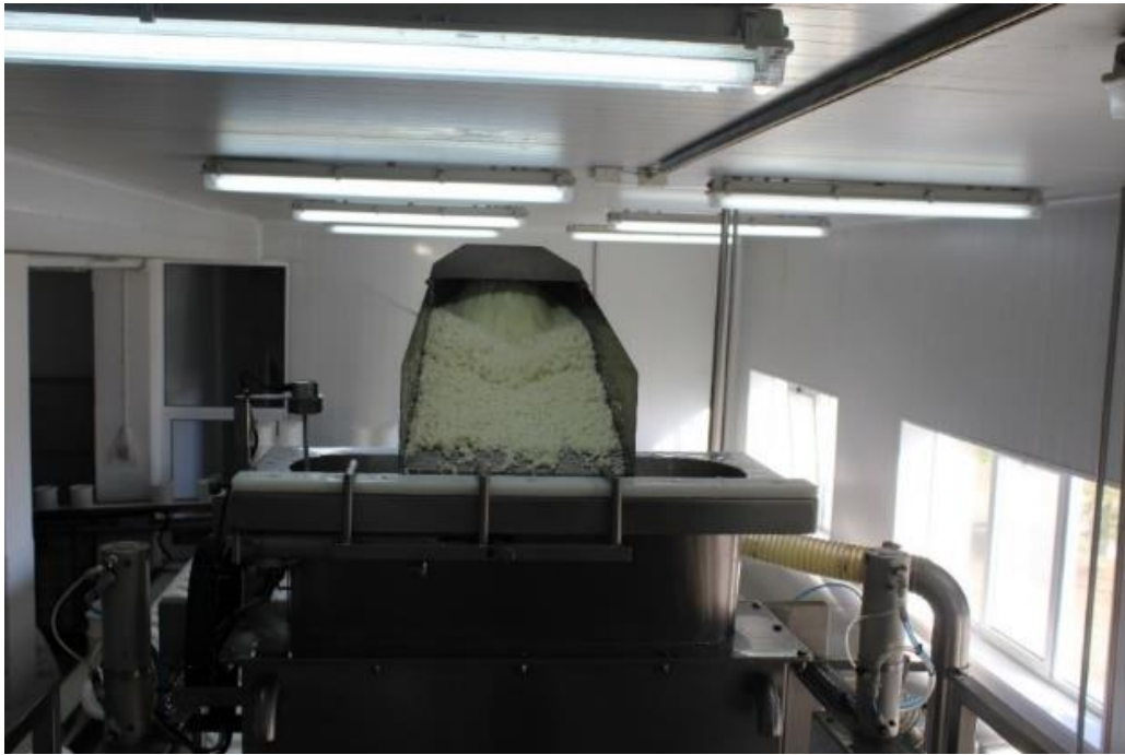
Figura 14. Bombeamento da matéria
