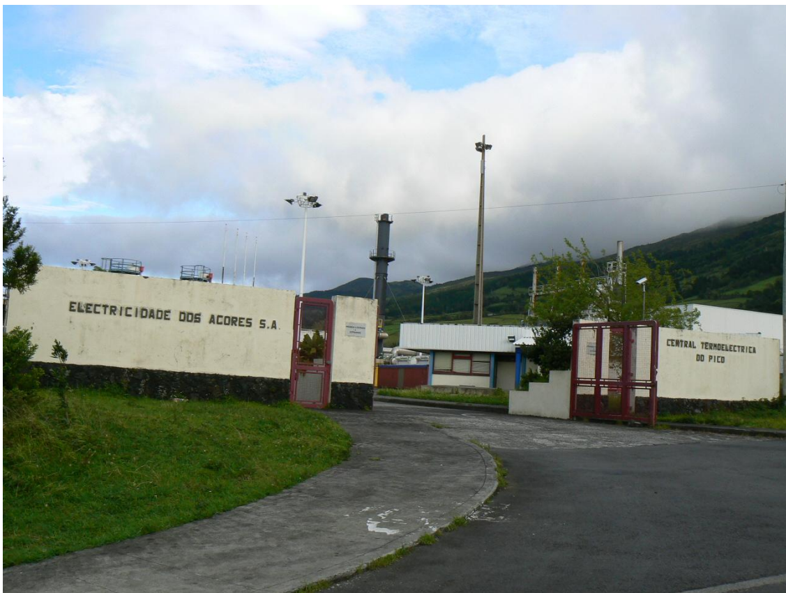
Fig. 3.1.1. - Central Termoelétrica de São Roque.
