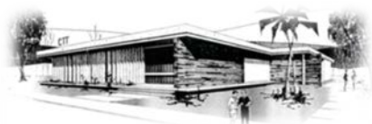
Imagem 41 - Estação dos CTT de Cabinda, do arquitecto Simões de Carvalho, em 1969.
