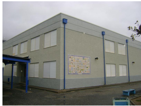
Figura I.7. - Pavilhão de Salas de Aula
