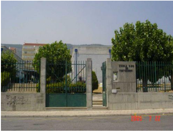
Figura I.4. - Entrada Principal da Escola
