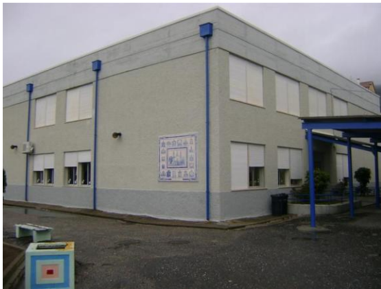
Figura I.6. - Pavilhão de Serviços Administrativos
