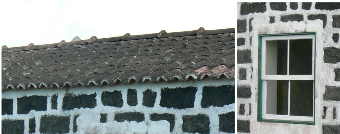
Fig. 4.3.8. – À esquerda – cobertura, à direita – janela.
