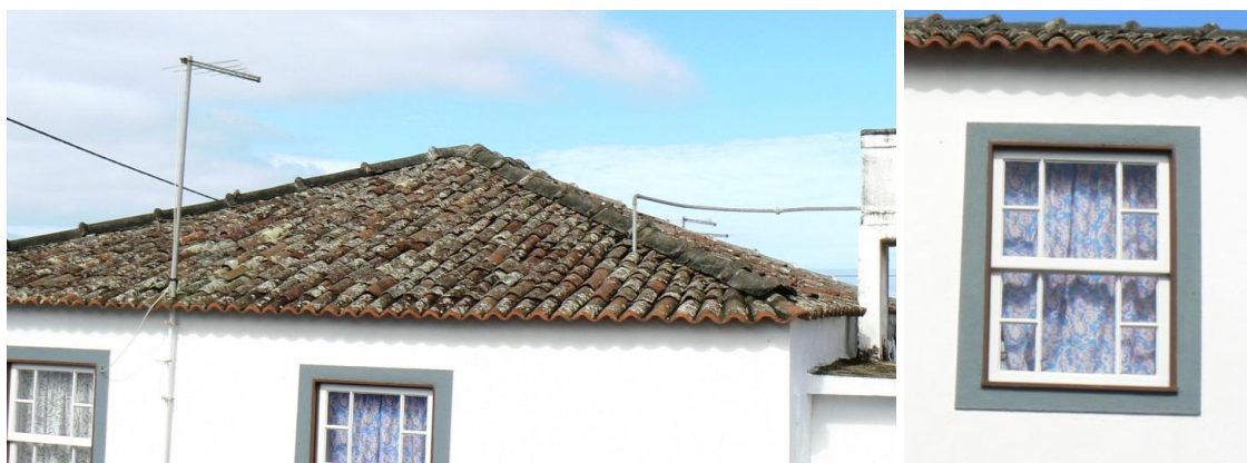
Fig. 4.3.2. – À esquerda – cobertura, à direita – Janela.
