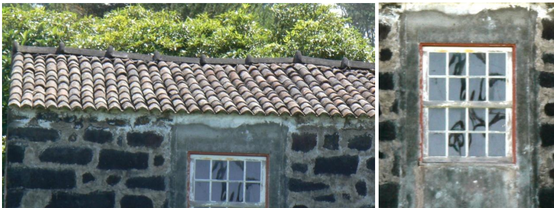
Fig. 4.3.5. – À esquerda – cobertura, à direita – janela.
