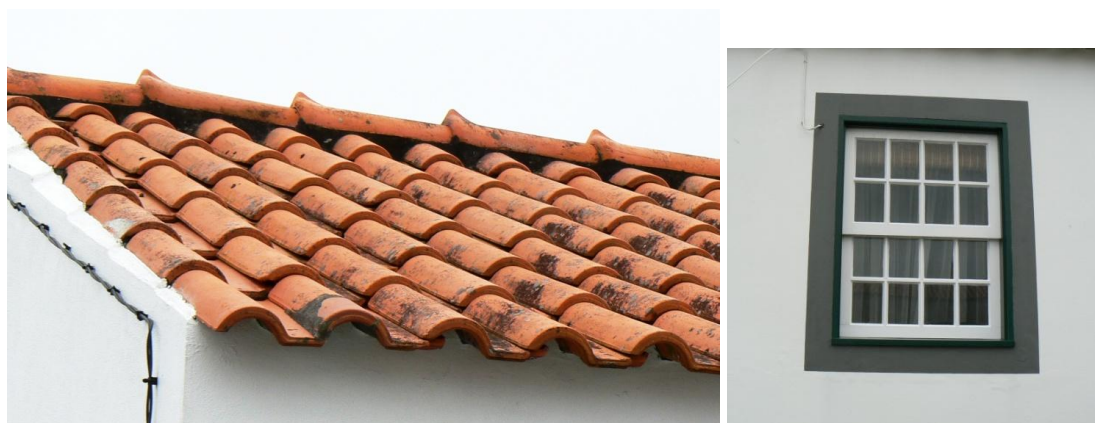
Fig. 4.3.14. – À esquerda – cobertura, à direita – janela.
