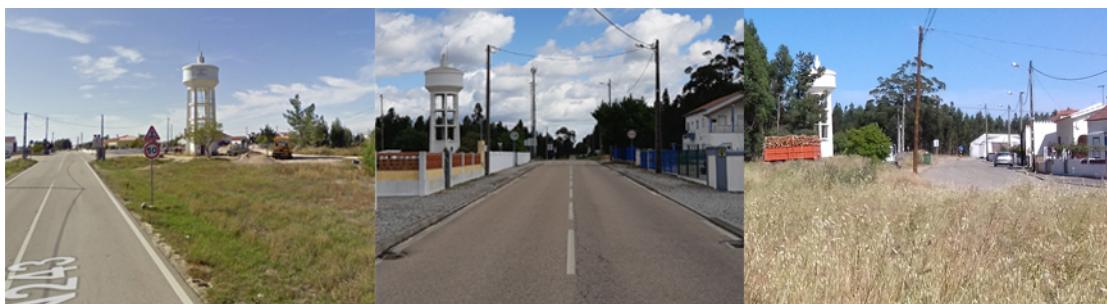
Figura 30 - Reservatório de água, 2019
