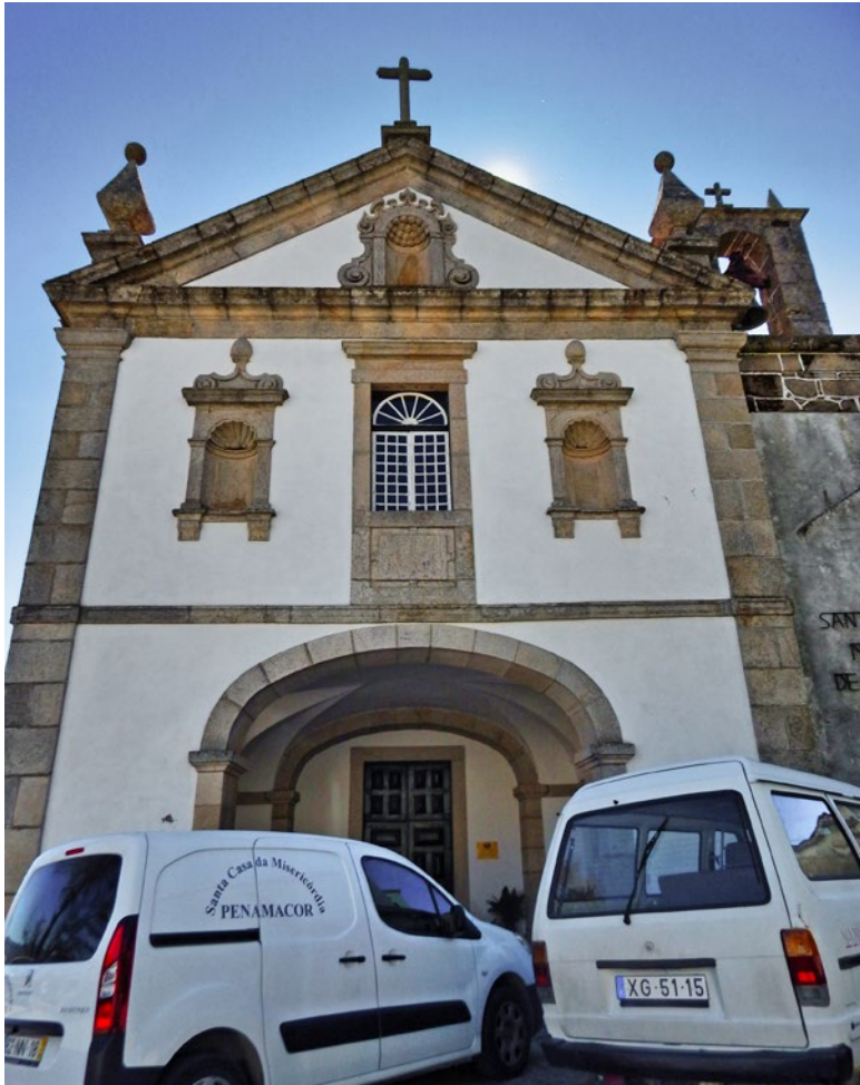
[Fig. 01] Fachada da Igreja do Convento de Santo António de Penamacor. (Imagem da autora)
