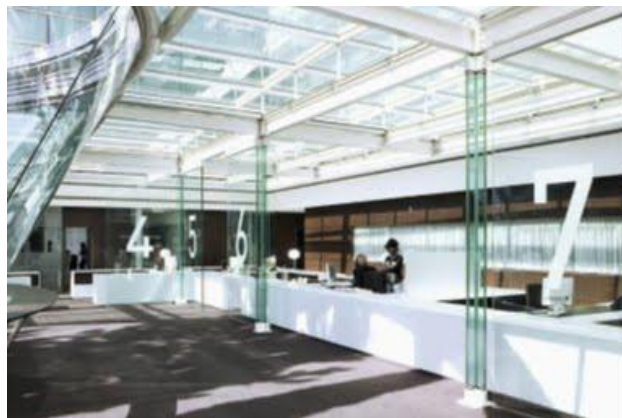
Figura 86. Pilares em vidro em Centro de Convenções em Saint German na França.
