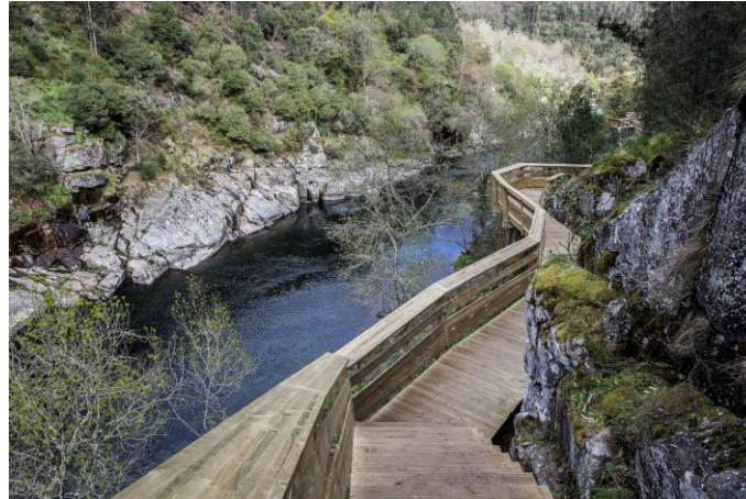
Fig. 48 - Passadiço do Geoparque de Arouca; Fonte: WEB 53; Autor: Adriano Miranda.
