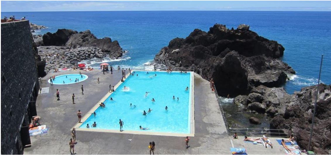
Figura 31, Vista Geral das Piscinas do Atlântico (Pinterest, S.d.)
