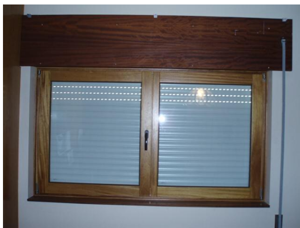
Figura 15 – Exemplo de caixilharia em madeira depois da reabilitação
