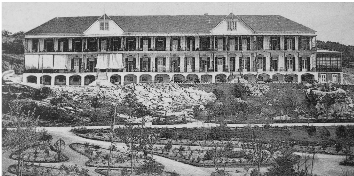
Figura 70 - Pavilhão Nº 1 Lopo de Carvalho depois da primeira ampliação
