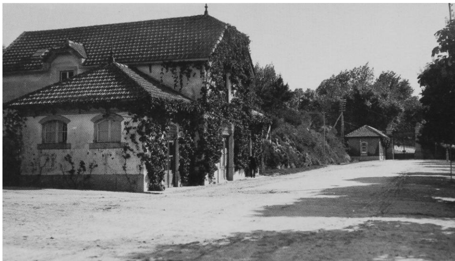
Figura 68 - Edifício da Administração
