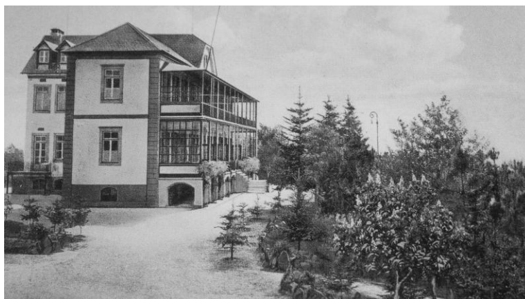
Figura 64 - Pavilhão Nº 2 António de Lencastre
