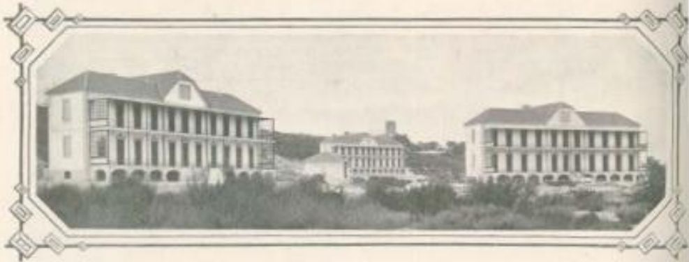
Tres corpos do edificio do Sanatorio
