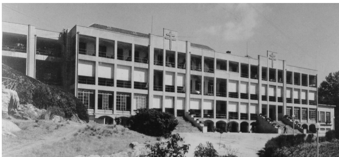
Figura 72 - Pavilhão Nº1 Lopo de Carvalho depois da segunda ampliação
