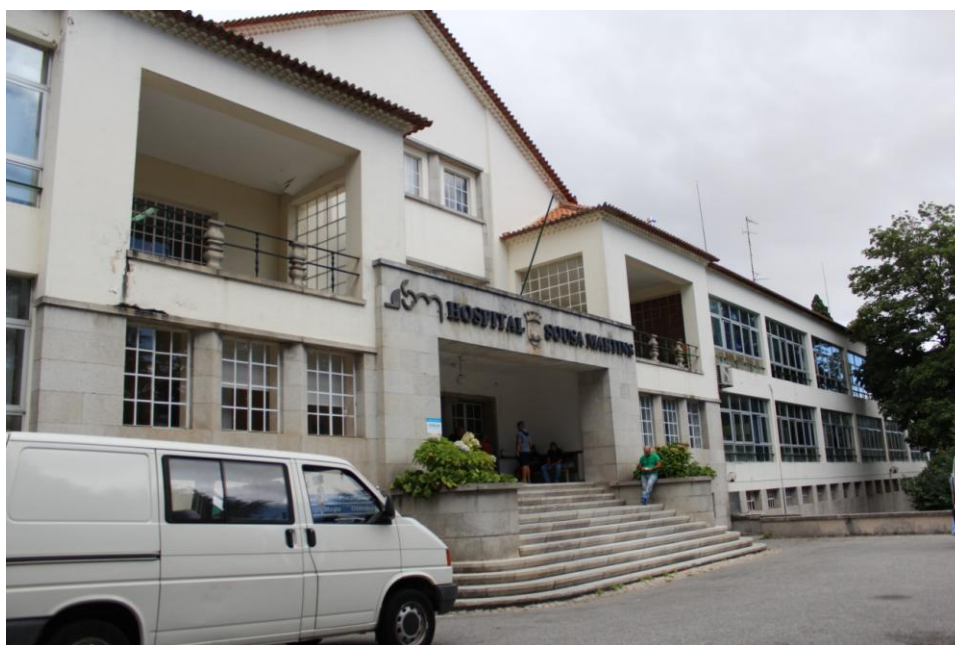
309 BORC Figura 86 - Hospital Distrital (antigo Pavilhão Novo)
