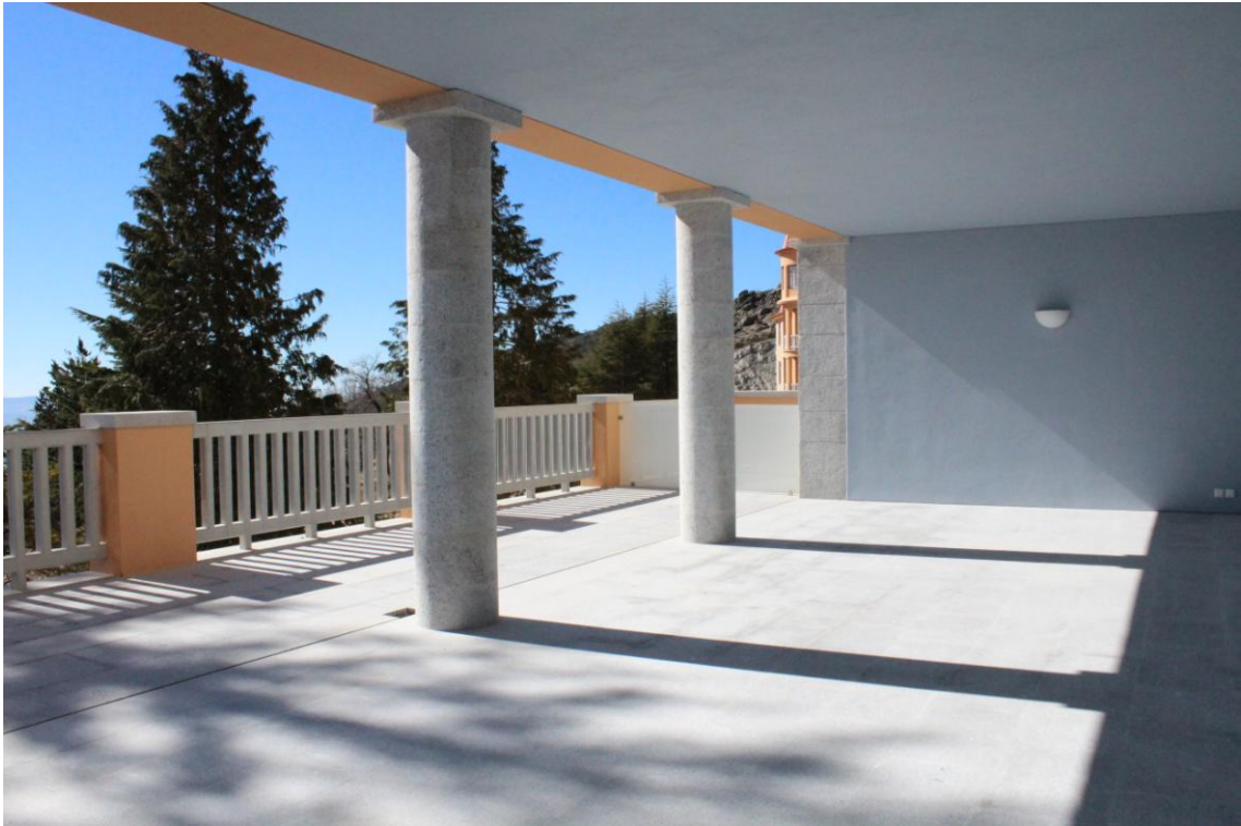
Fotografia da galeria de cura atualmente existente na Pousada
