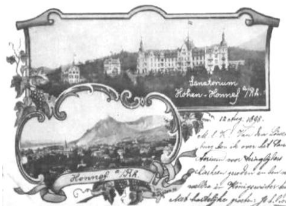
Figura 21 - Sanatório de Hohenhonnef
