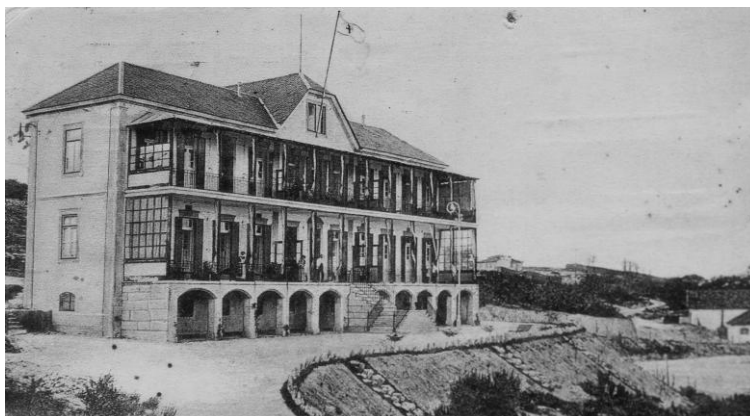
Figura 63 - Pavilhão Nº 1 Lopo de Carvalho
