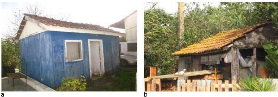
Figura 34 - Edifícios que revelaram o pior estado ao nível do EC, (a) edifício n.º 5A e (b) edifício n.º 26A.
