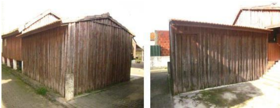
Figura 46 - Melhor exemplo da Matriz arquitetónica original das casas palafíticas avieiras de Caneiras - Palafita n.º 11A em 2016.
