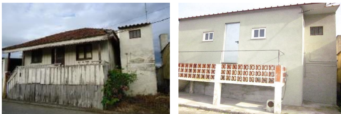
Figura 27 - Edifício com melhorias acentuadas ao nível do EC, (a) edifício n.º 22 em 2014 e (b) em 2016.
