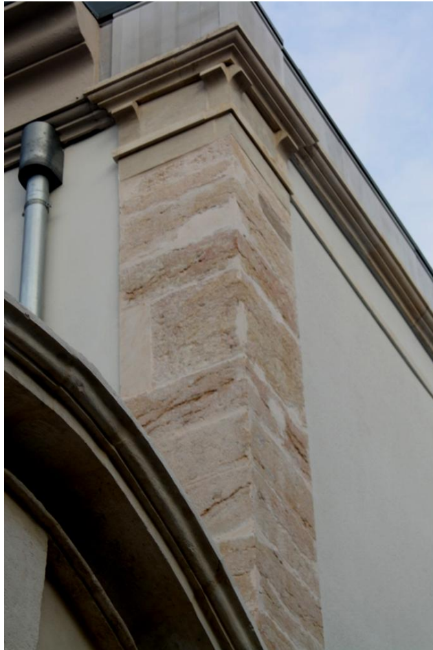
Figura 32 - Preenchimento com argamassa de parte dos blocos de alvenaria dos cantos de um edifício recentemente reabilitado em Leiria
