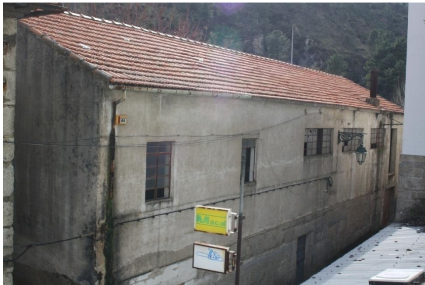
Figura 51 - Vista parcial de edifício anexo no Alçado Norte do edifício principal 2010
