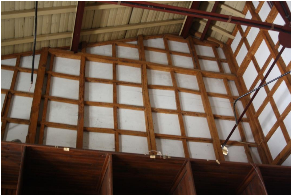
Figura 60 – Zona nascente do edifício: compartimentação interior com tabiques de madeira e gesso cartonado
