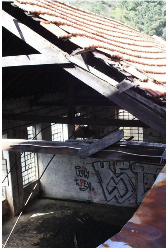
Figura 57 – Vista do interior e de parte da cobertura da zona poente do edifício
