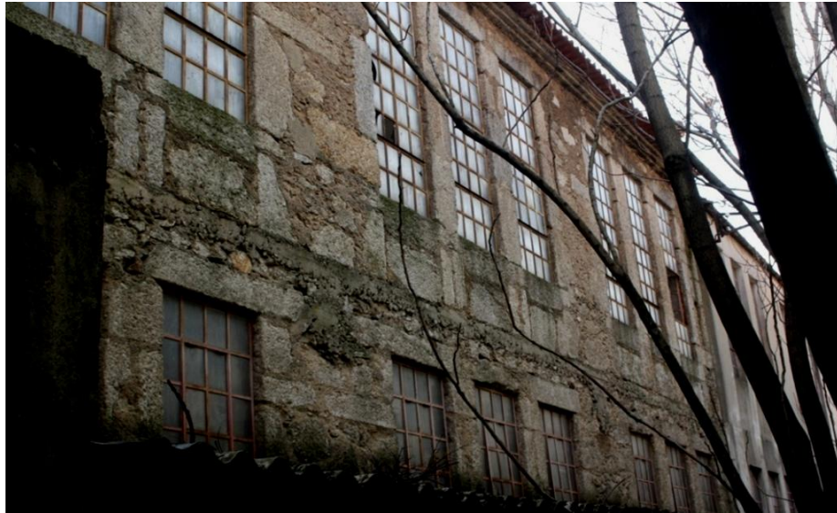
Figura 50 - Vista parcial do Alçado Norte do edifício principal 2010
