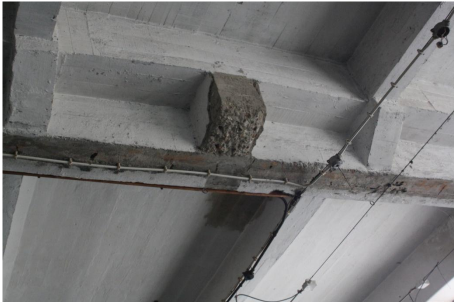
Figura 77 – Zona onde se vê claramente a remoção de um pilar existente no local.
