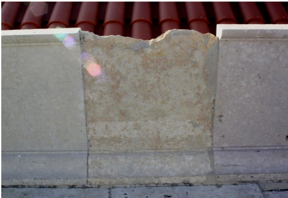
Figura 34 - Elementos de alvenaria substituídos e originais no Convento de Cristo, Tomar
