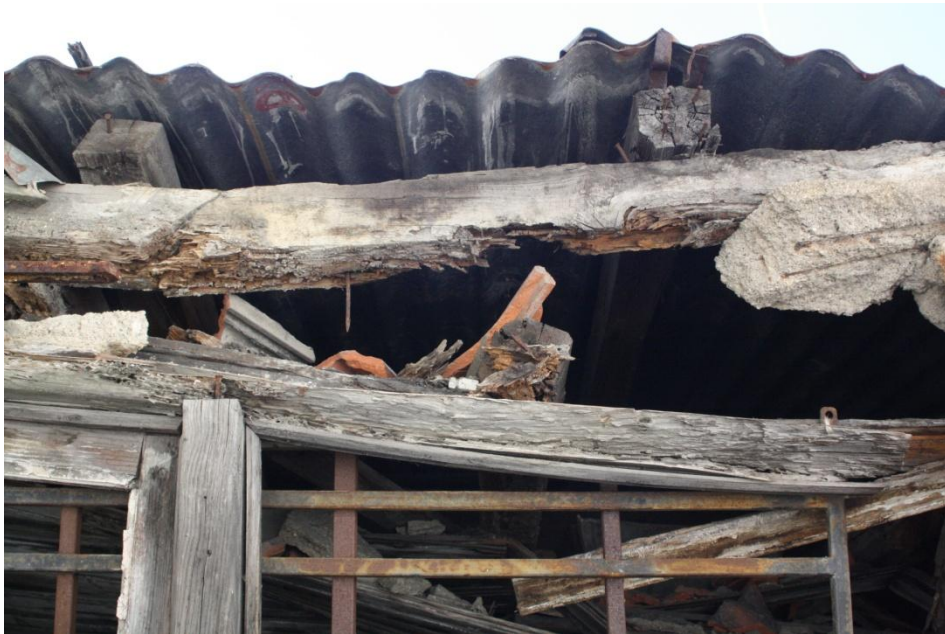
Figura 63 – Degradação de elementos de madeira e metal diversos, quer da cobertura, quer da restante estrutura do edifício
