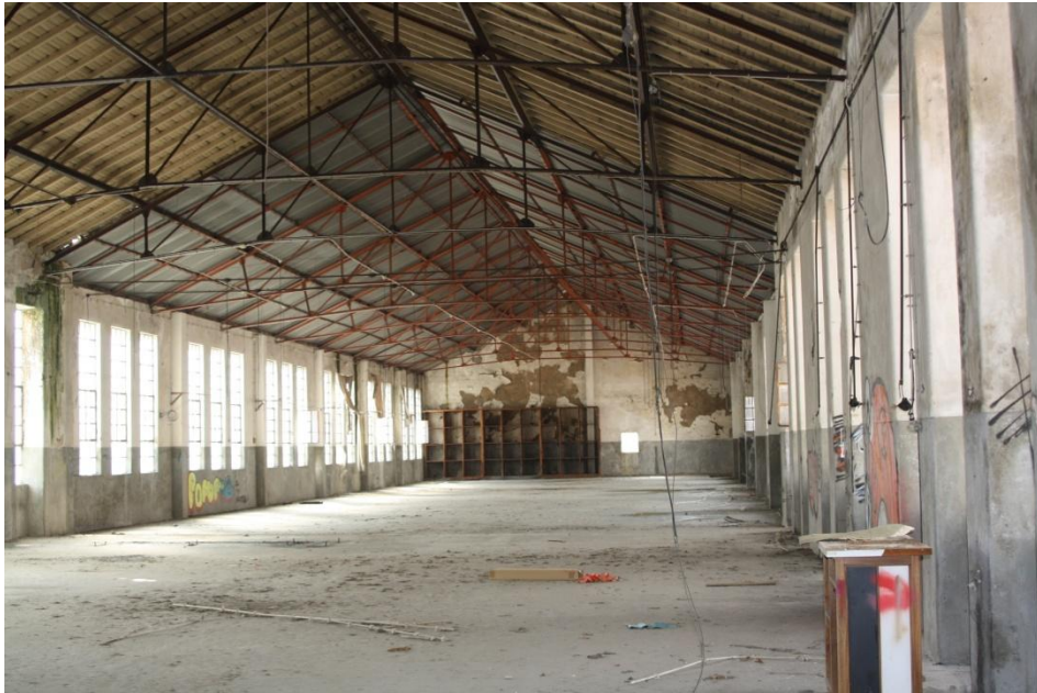
Figura 55 – Vista interior do piso 4
