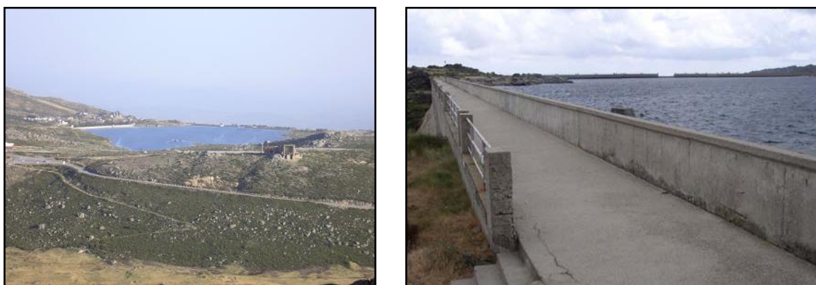
Figura 1.1 - Barragem da Cova do Viriato.
