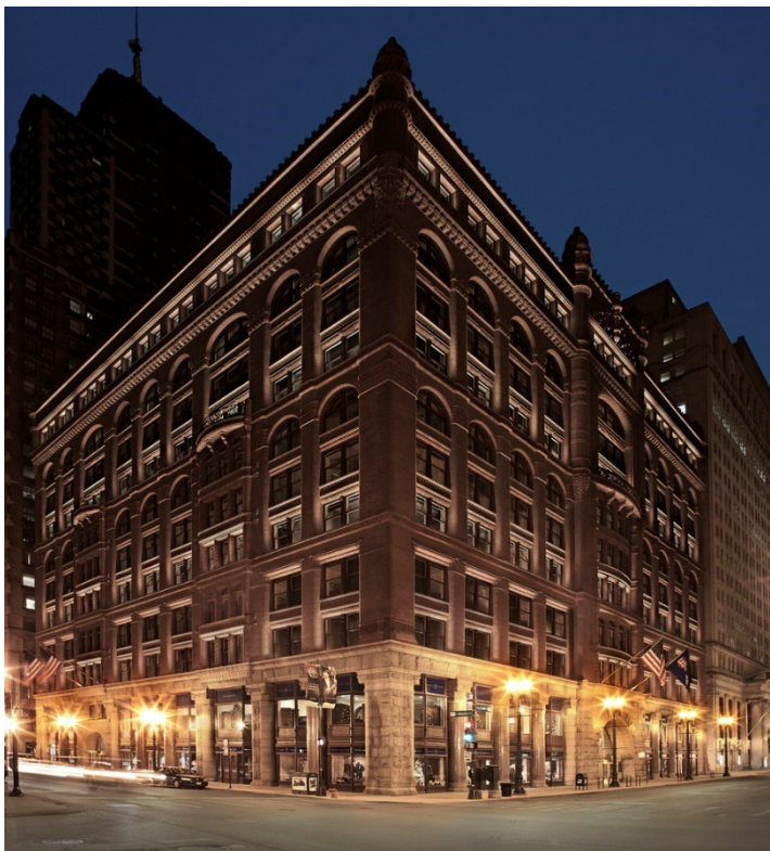
Figura 12. Fotografia em perspectiva do edifício The Rookery, em Chicago (retirado de Schielke, 2021), fotografia (Adam Daniels).
