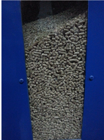
Figura 5.1.6. Sistema a pellets de biomassa numa empresa de tinturaria no Norte de Portugal - pellets de biomassa no depósito.
