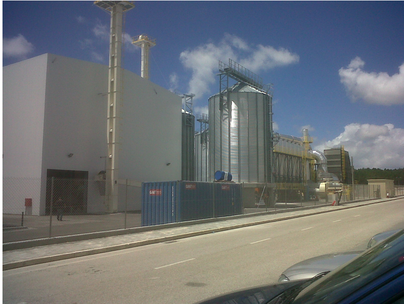
Figura 5.1.9. Grande unidade de produção de pellets de biomassa, com uma capacidade de produção de cerca de 130.000 toneladas por ano, localizada na zona centro de Portugal.
