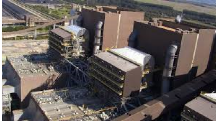
Figura 5.4.3. Pormenor dos grupos geradores que constituem a central ( www.edp.pt ).
