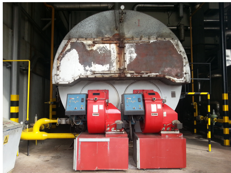
Figura 5.3.4. Caldeira a vapor com 2 queimadores a gás natural que produz 20 t/h de vapor a 10 bar.
