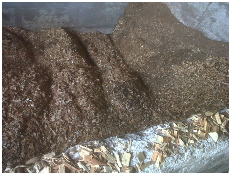
Figura 5.3.12. Sistema automático de alimentação de estilha de biomassa. Nesta figura apresenta-se o depósito de estilha de biomassa.
