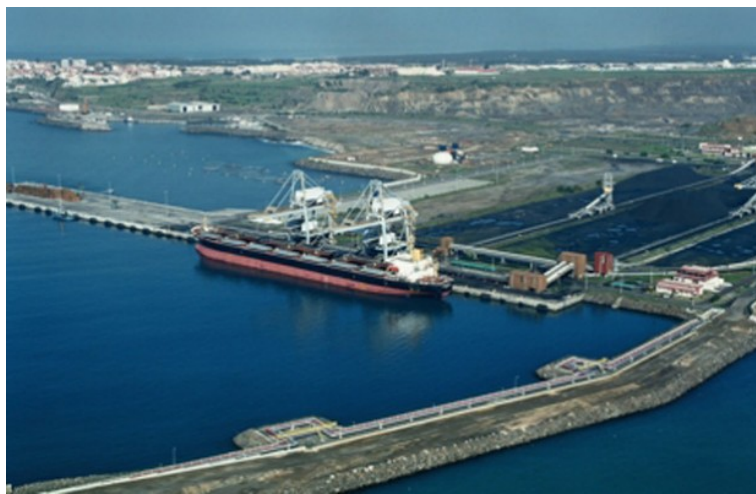
Figura 5.4.4. Barco a efetuar a descarga de carvão para a Central Termoelétrica de Sines ( www.edp.pt ).
