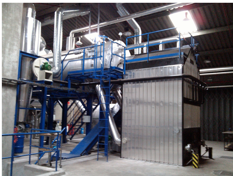
Figura 5.3.6. Queimador a biomassa numa caldeira de vapor que utiliza pellets de biomassa.
