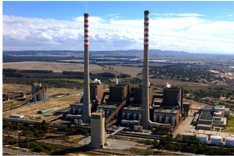
Figura 5.4.7. Chaminés da Central Termoelétrica de Sines ( www.edp.pt ).
