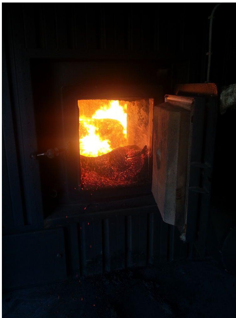
Figura 5.5.12. Aspeto do interior da fornalha com a combustão de pellets de biomassa torrificada.
