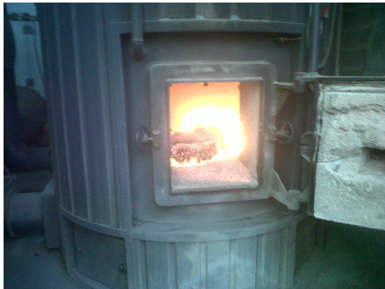
Figura 5.1.5. Exemplo de um sistema de aquecimento instalado numa unidade de produção de pellets de Madeira e que alimenta uma estufa onde se efetua o choque térmico, como medida preventiva para a dispersão do nematode do Pinheiro.
