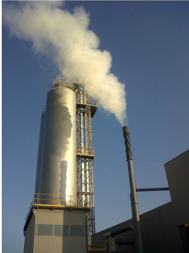
Figura 5.5.10. Instalações da YGE - Yser Green Energy SA, situada em Oliveira de Azeméis (Portugal).
