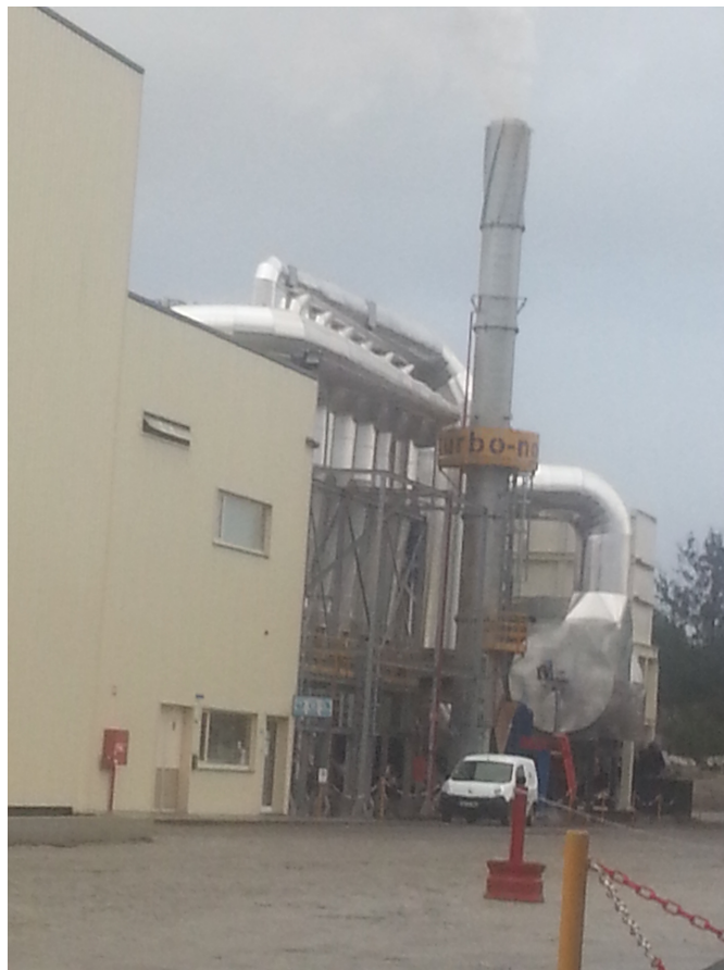
Figura 5.1.10. Grande unidade de produção de pellets de biomassa, com uma capacidade de produção de cerca de 100.000 toneladas por ano, localizada na zona Norte de Portugal.
