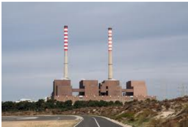
Figura 5.4.2. Quatro geradores da Central de Sines (www.edp.pt).
