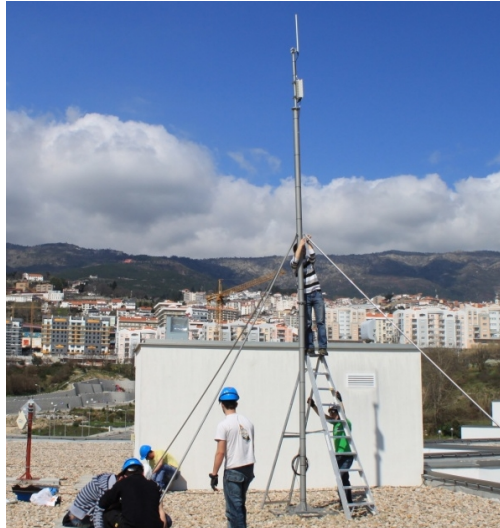
Figura 5.5 - Elevação da antena da BS.
