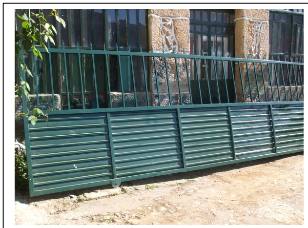
Recuperação de portão em ferro
