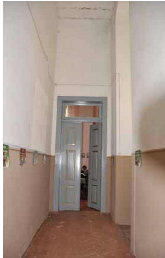
Figura 5.12- Corredor interior do edifício
