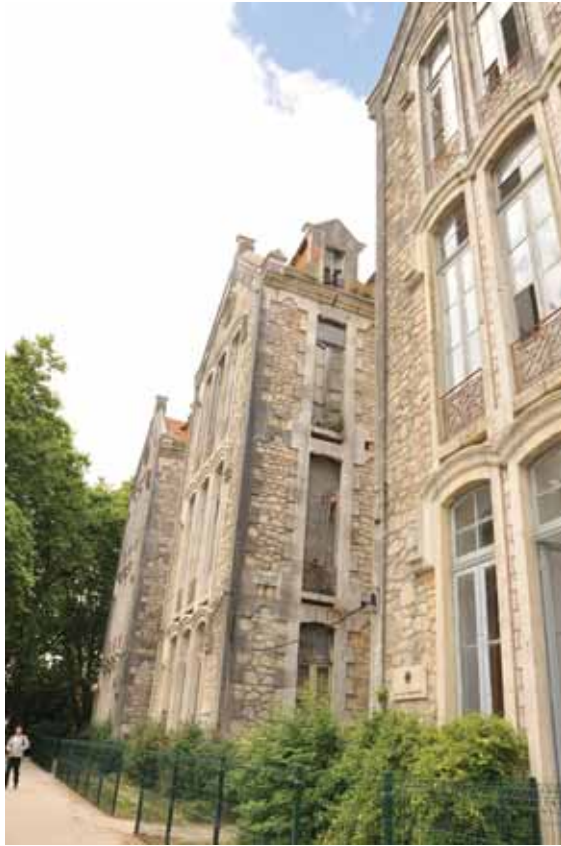
Figura 5.1- Corpos frontais do edifício, Oeste
