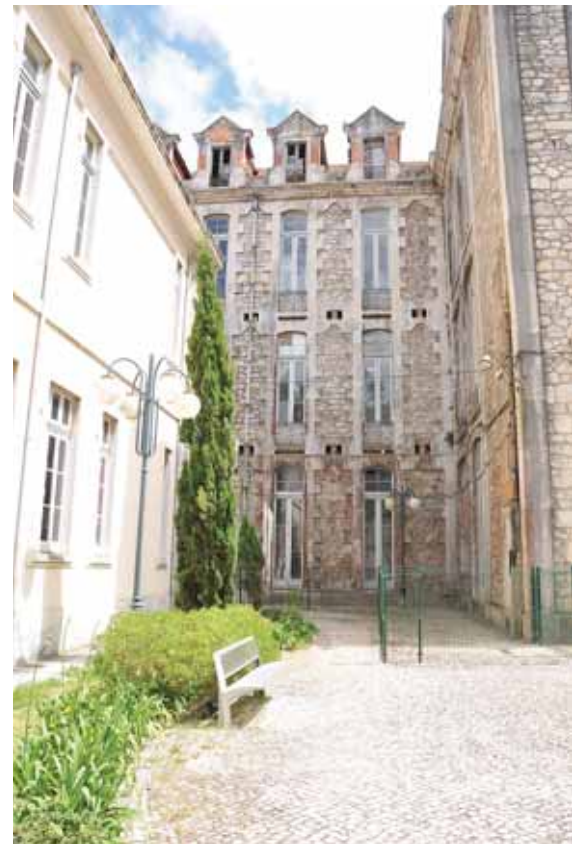
Figura 5.5 -Fachadas junto ao Balneário Termal, Norte
