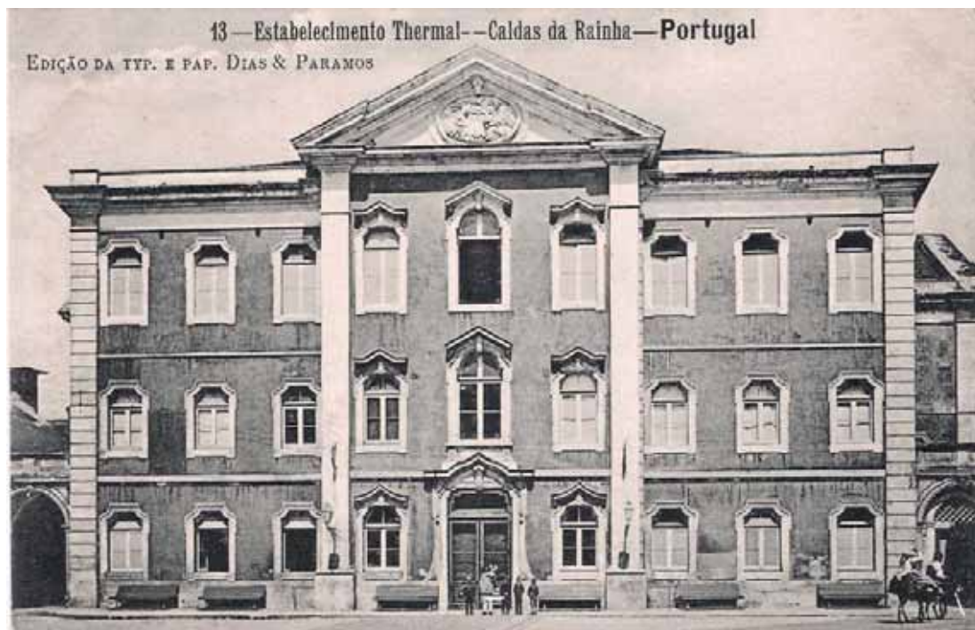
Figura 3.8- Hospital depois da Ampliação
