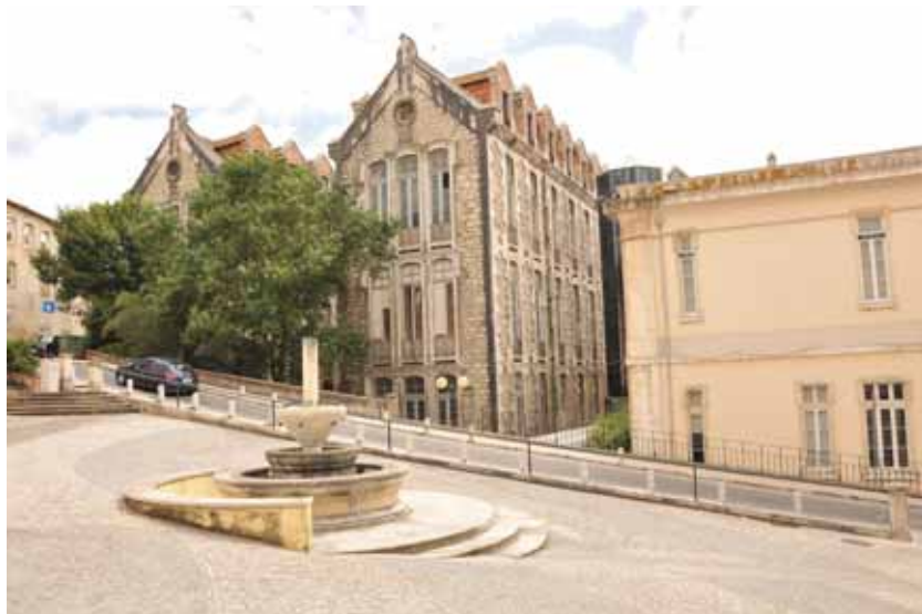
Figura 5.7- Vista da Fachada Posterior, Este.
