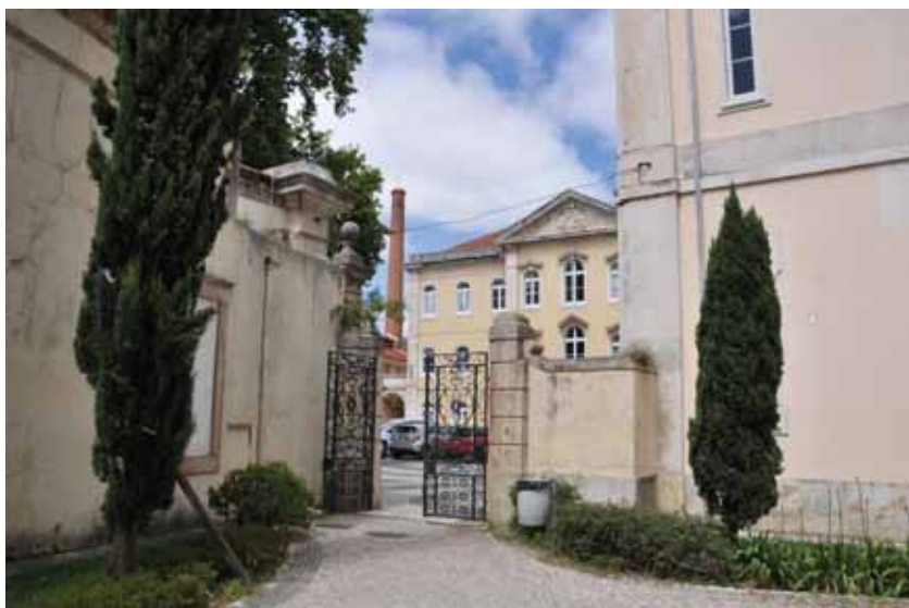
Figura 5.8-Vista do Hospital Termal. Entrada Norte
