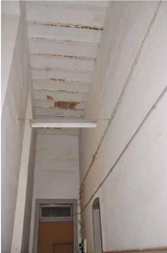
Figura 5.9 -Interior do Edifício, Corpo a Sudoeste.
