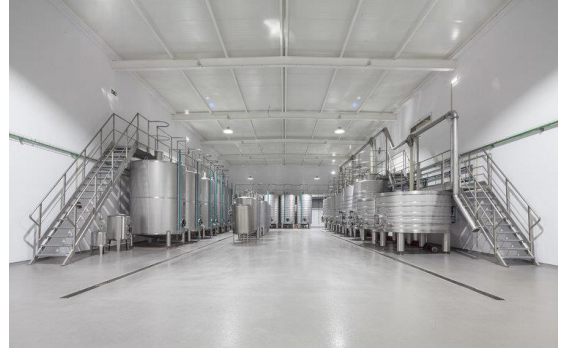
[ 28 ] Adega 23, sala de armazenamento em cubas.
