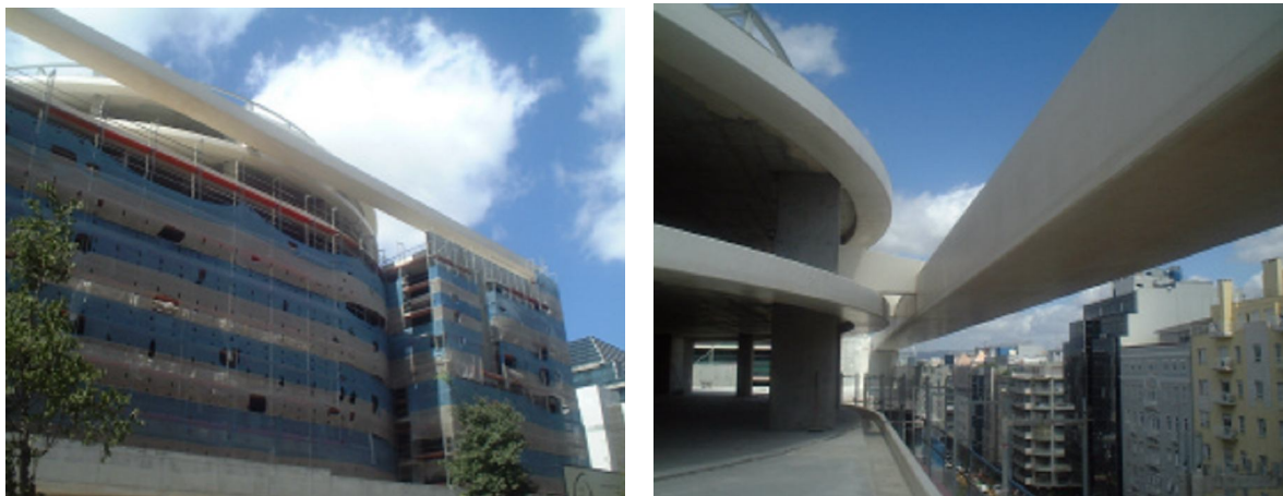
Figuras 2.2 - Viga de Coroamento do Edifício Alto Parque ( Rilem-Seminário Novos Desenvolvimentos do Betão , Lisboa, Setembro 2003 “Betões de elevado desempenho arquitectónico”)
