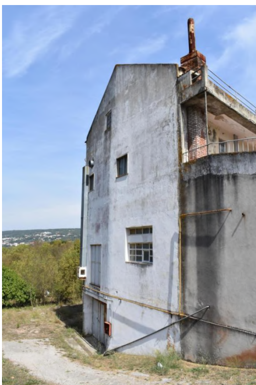
Figura 83 - Acessos para cargas e descargas no alçado Oeste do volume fabril.
