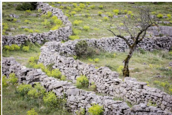
Figura 20 - Muro limitador de áreas e caminhos em construção de junta seca - Porto Mós.
