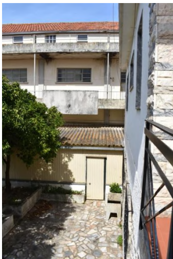
Figura 97 - Terraço presente entre o jardim e a moradia.
