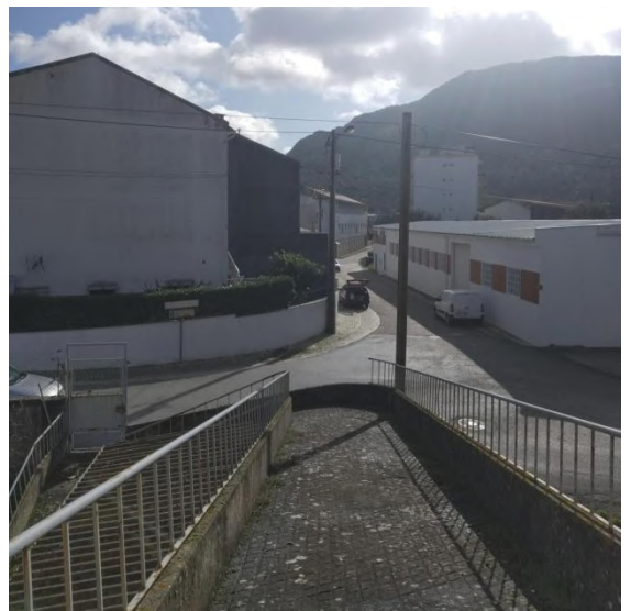
Figura 89 - Rampa fabril em betão.
