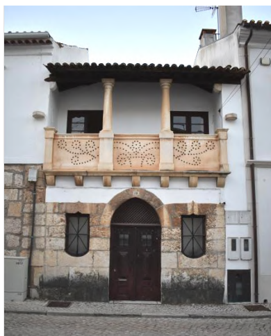
Figura 29 - Exemplo de edifício residencial tradicional com grossas cantarias.
