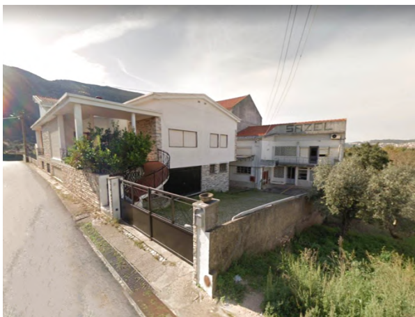
Figura 80 - Entrada principal administrativa.
