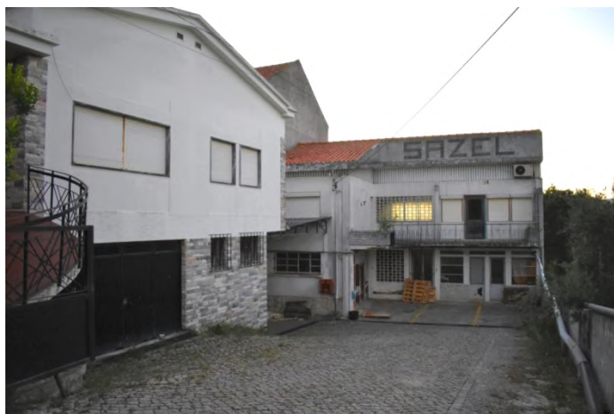
Figura 91 - Fachada sul do corpo administrativo.
