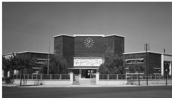
Figura 62 - Entrada Fabril da Casa da Moeda
