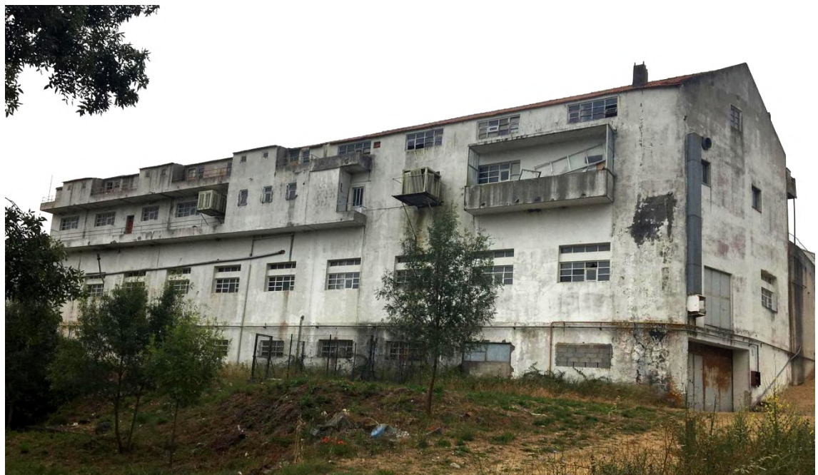
Figura 90 - Fachada Norte do corpo de produção.
