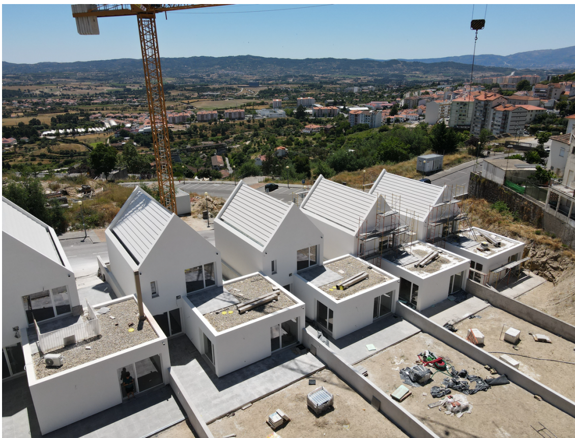
Figura 5.3 – As moradias em construção possuem vistas privilegiadas sobre a Cova da Beira (Fotografia aérea com recurso a drone realizada pelo autor, 2020).
