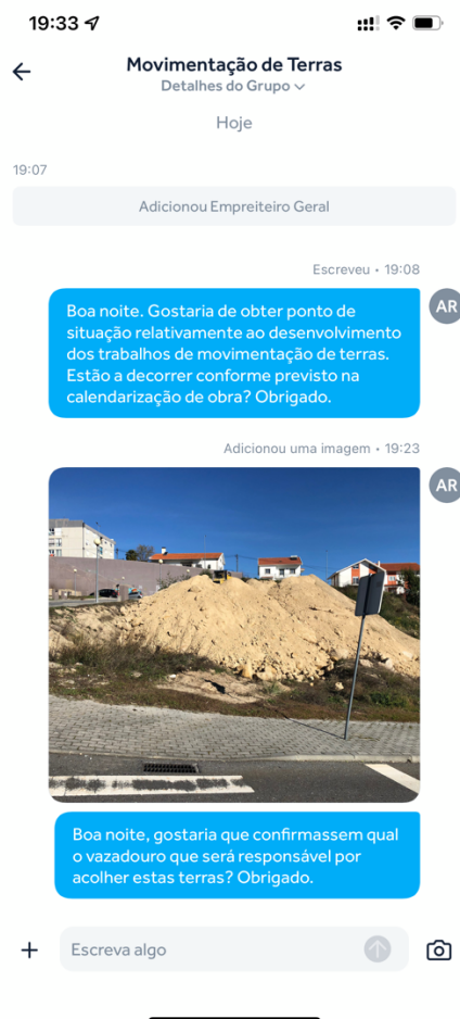
Figura 5.15 – Colocação de questões ao empreiteiro-geral e ao subempreiteiro responsável pela movimentação de terras na empreitada em análise através do chat integrado no FinalCad .
