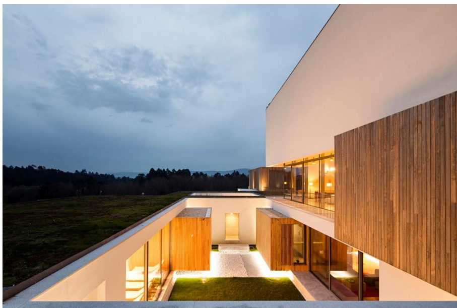
Figura 20– Vista da cobertura da ampliação do Hotel Minho.
