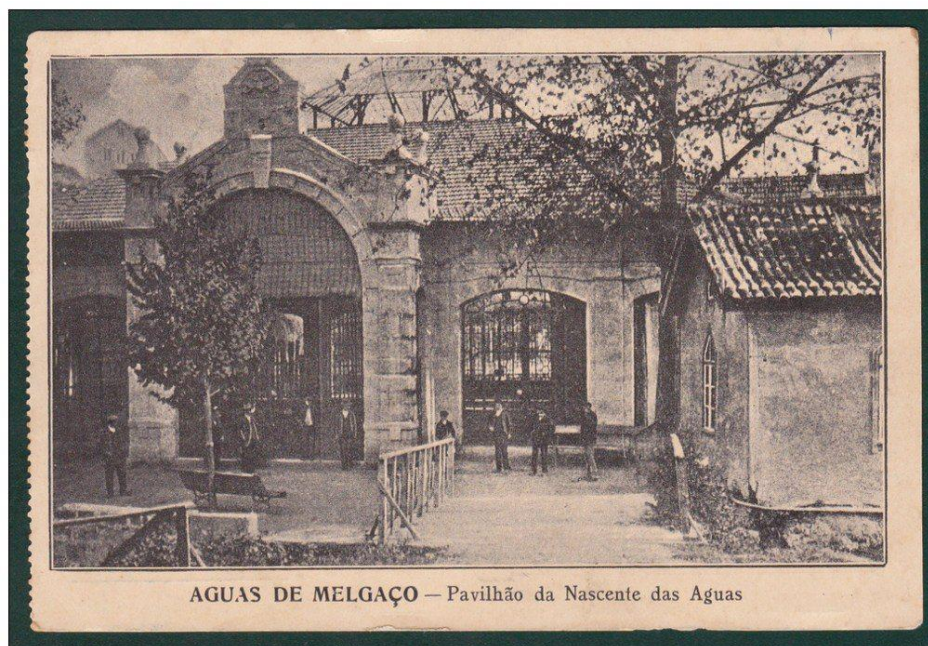
Figura 13– Fotografia séc. XX do Pavilhão da Nascente das Águas de Melgaço.
