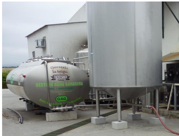
Fig.4. 37- Panorama de geral do permutado de calor.
