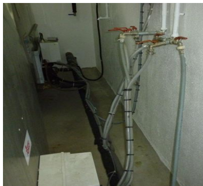
Fig.4.3-Pormenor da entrada da água nos tanques para lavagem.
