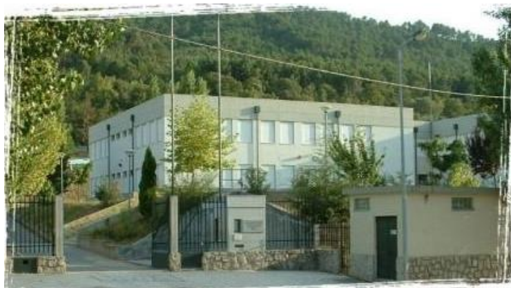
Figura 12 - Escola EB 2,3 Serra da Gardunha.
