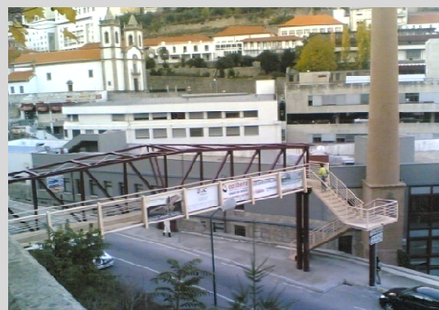
fig. 10 – Em primeiro plano, as actuais instalações do departamento de Matemática, antiga fábrica de Sebastião da Costa Rato.
