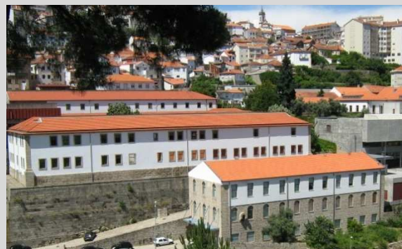
fig. 14 – Instalações actuais das Ciências Farmacêuticas. Antigo edifício fabril de José Mendes Veiga/João Bernardo Gíria. Note-se os traços preservados do estado da obra antiga.
