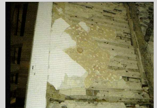
fig. 68 – Parede Pombalina (séc. XVIII-XIX). Pormenor do revestimento em várias camadas.
