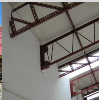
fig. 53 – À esquerda, cobertura da ala Norte em painéis sandwich. À direita, estrutura da cobertura da ala Norte em vigas treliçadas.
