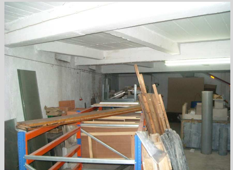
fig. 49 – Vista da rede de vigas que sustentam a laje divisória entre piso 0 e piso 1.
