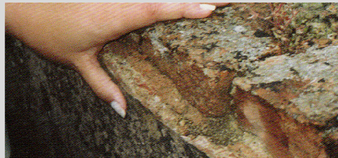
fig. 66 – Reboco romano em Conímbriga. Conforme a irregularidade da parede, as várias camadas do reboco podem alcançar espessuras acima dos 5cm.
