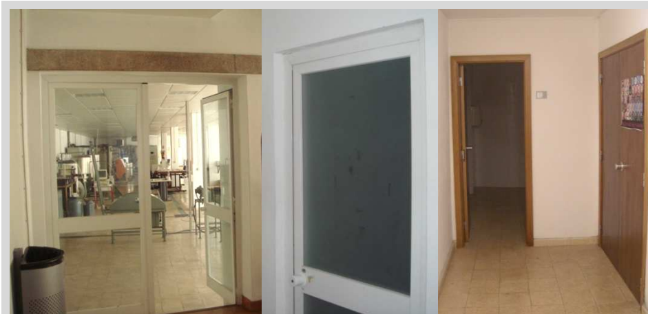
fig. 55 – À esquerda e no meio, vistas das portas de caixilharia em PVC lacadas a branco, no interior do edifício.
