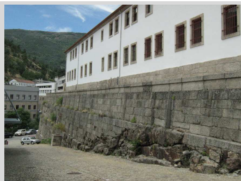
fig. 41 – Aspecto actual da antiga Real Fábrica Veiga. Destaca-se a sua imponente base de assentamento em pedra granítica da região.
