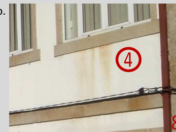
fig. 79 – Tipo 4: sujidade da fachada causada pela oxidação de partículas de ferro contidas na pedra que emoldura as janelas.
