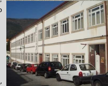
fig. 54 – Em cima, vista das janelas com caixilharia em PVC. Em baixo, veja-se as portas metálicas lacadas a encarnado.
