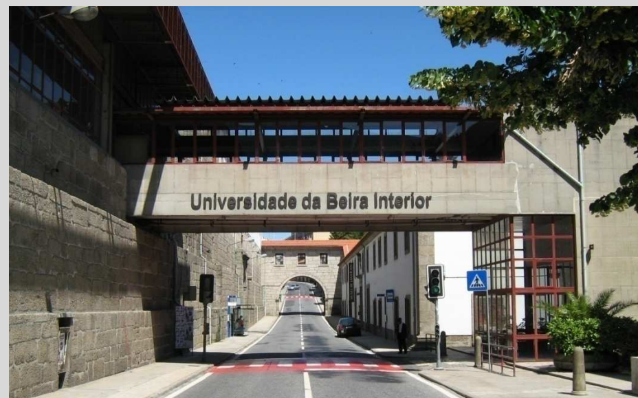
fig. 39 – Representação gráfica da ideia da “linha”. Passagens sobre a Rua Marquês d’Avila e Bolama, antigo arco da Real Fábrica de Panos (em segundo plano) e passagem construída pela UBI (em primeiro plano).
