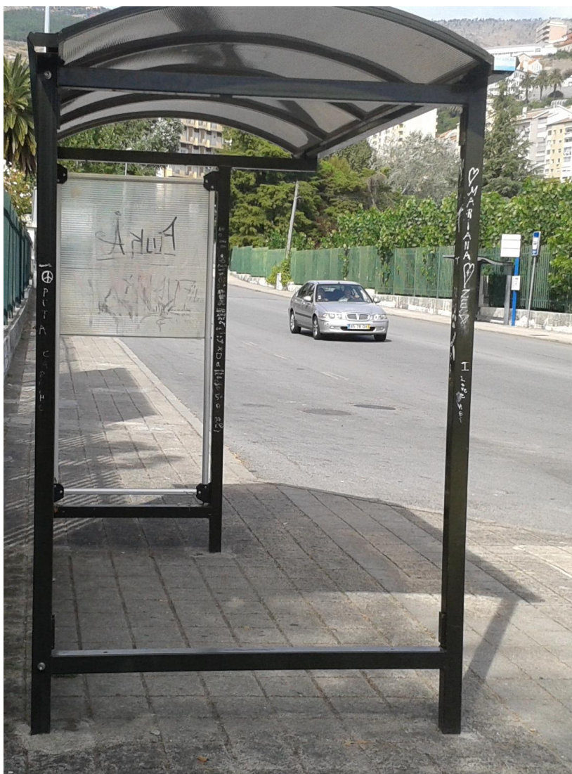
Figura 7 - Ponto de paragem sem protecção e sem assento.
