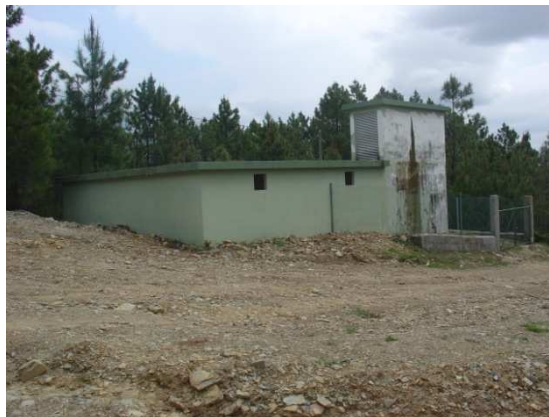
Figura 20- Estação de tratamento e reservatório de armazenamento de 100 m 3
