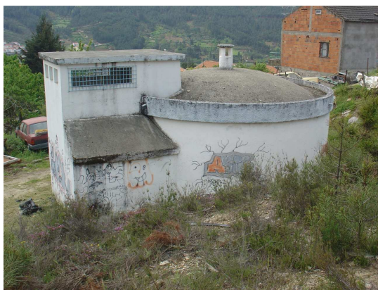
Figura 21- Reservatório de distribuição de 100 m 3
