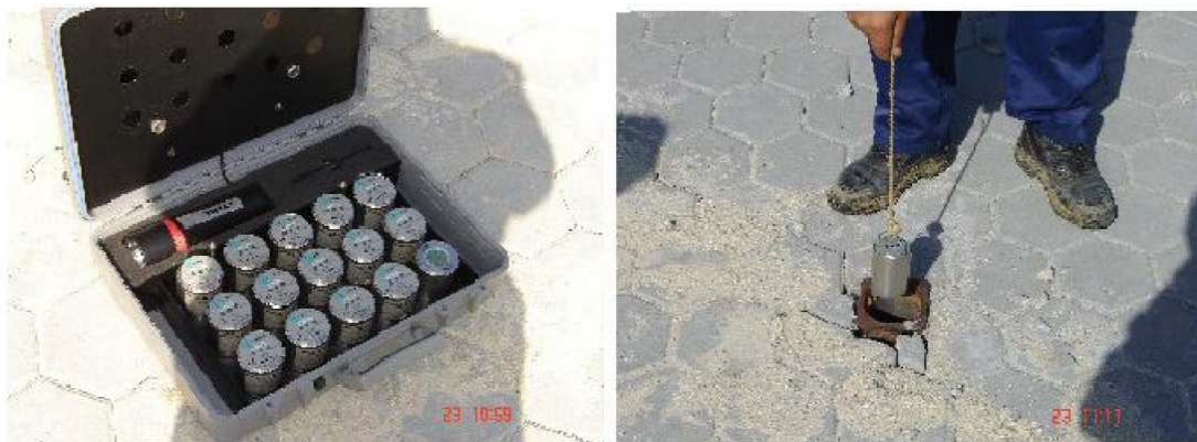
Figura 12- Dataloggers e sua colocação sobre uma válvula de seccionamento (Antunes et al. , 2009)
