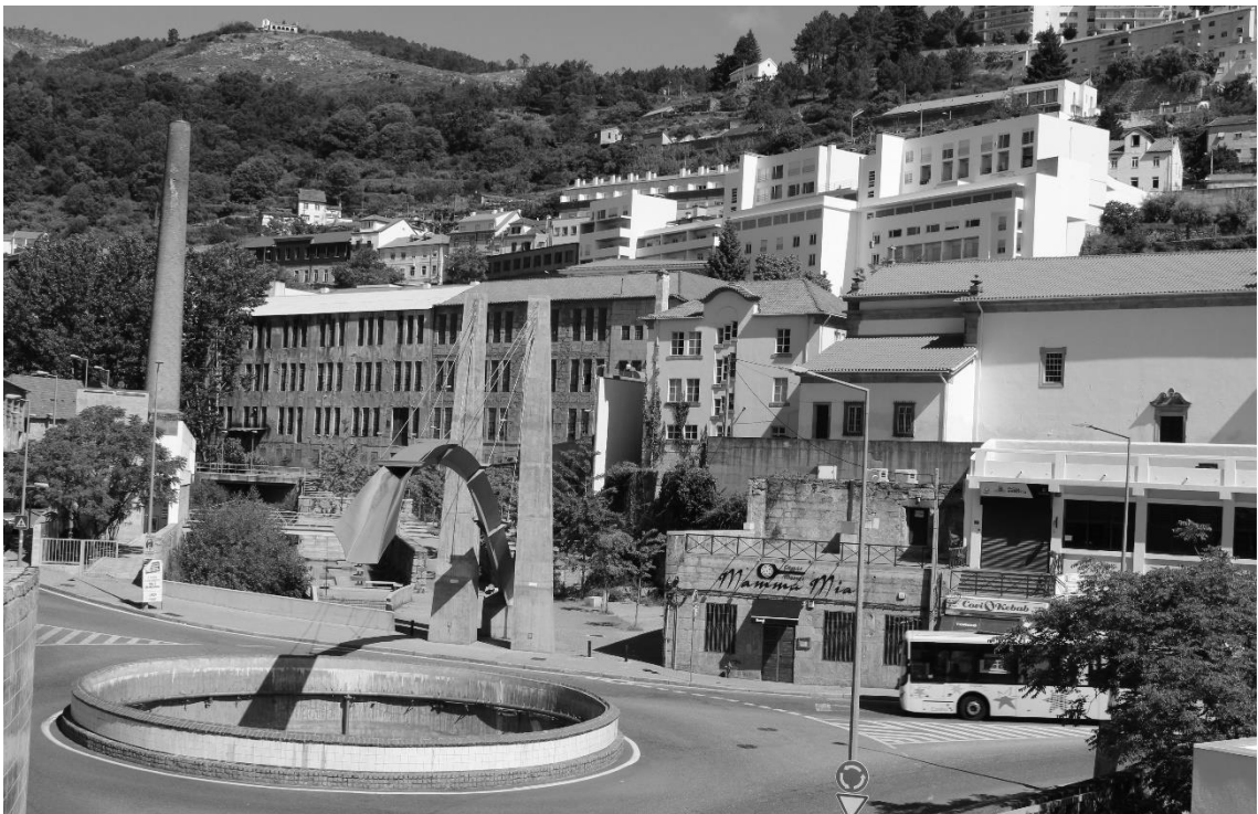
Img 16- Mural relacionado com os lanifícios integrado na reabilitação da Rotunda do Rato, 2013. Img 19- Conversão do antigo complexo turístico em galeria de exposições, 2018. Img 20 – Relação da intervenção com a envolvente, 2018.
