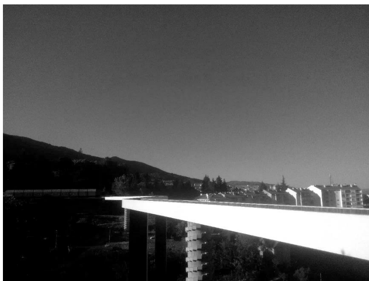
Img 21- Esquema de “aplanar a cidade”, Nuno Teotónio Pereira, 2004 (Pereira N. T., 2009, p. 42) Img 22 – Elevador do Jardim e ponte da Carpinteira, 2018. Img 23 – Ponte da Carpinteira, projeto de Carrilho da Graça, 2017.
