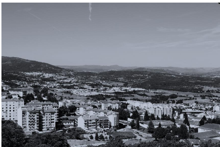
Img 36- A imagem da cidade marcada pelas traseiras do edificado, 2017. Img 37 – O centro histórico envolto em edifícios multifamiliares, 2018. Img 38 – Zona nova da cidade marcada pelo crescimento em altura, 2018.
