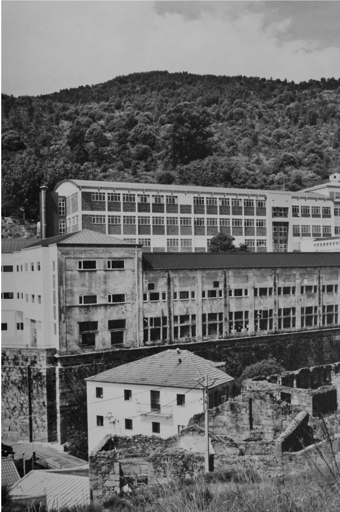
Img 15- Complexo fabril da antiga empresa Ernesto Cruz & C.ª, reconvertido para instalação da Faculdade das Ciências Sociais e Humanas, 2009. (Pinheiro, 2009, p. 107)
