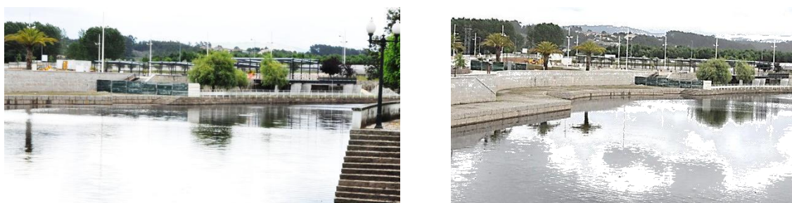
Figura 21 - Largo 1º de Maio ou Largo da Botaréu em obras de regeneração urbana, [Fonte: Autor, 2012]
