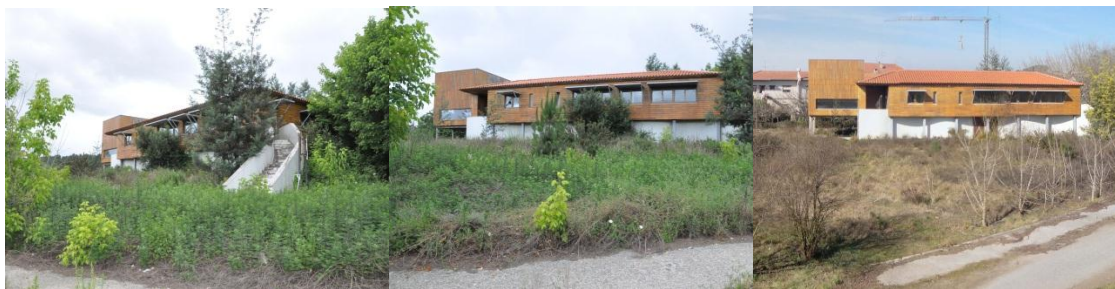
Figura 24 - Centro de Canoagem e sua envolvente (margem Sul), [Fonte: Autor, 2012]
