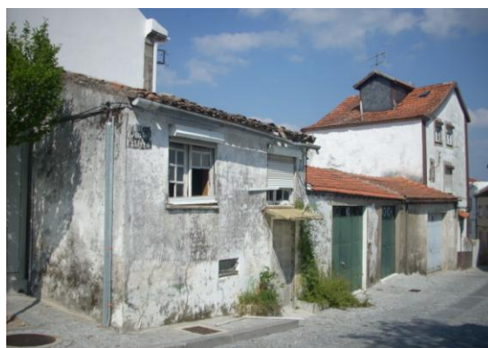
Foto. 4 - Fachada da Rua do Castelo.
