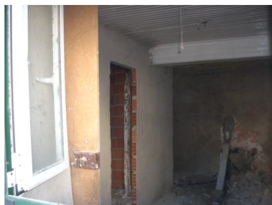
Fig. 29 - Obras Paradas no Interior do Edifício A.
