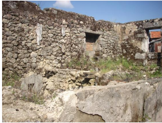
Fig. 30 - Interior do Edifício B.
