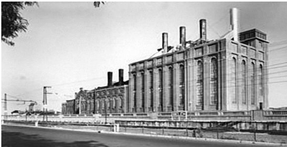
Fig. 12 - Conjunto da Central Tejo Após a Instalação da Última Caldeira, 1948.
