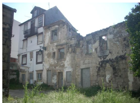
Foto. 2 - Fachada do Interior do Pátio.
