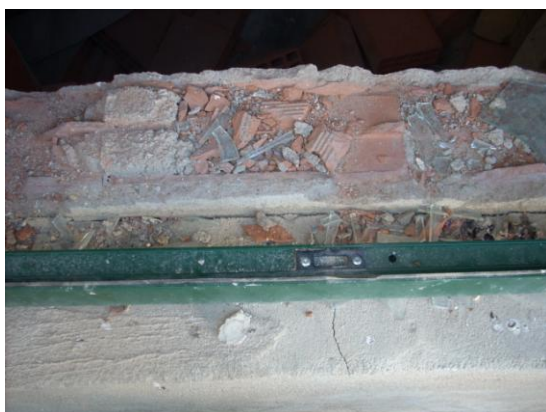
Fig. 28 - Pormenor da Parede do Edifício A.
