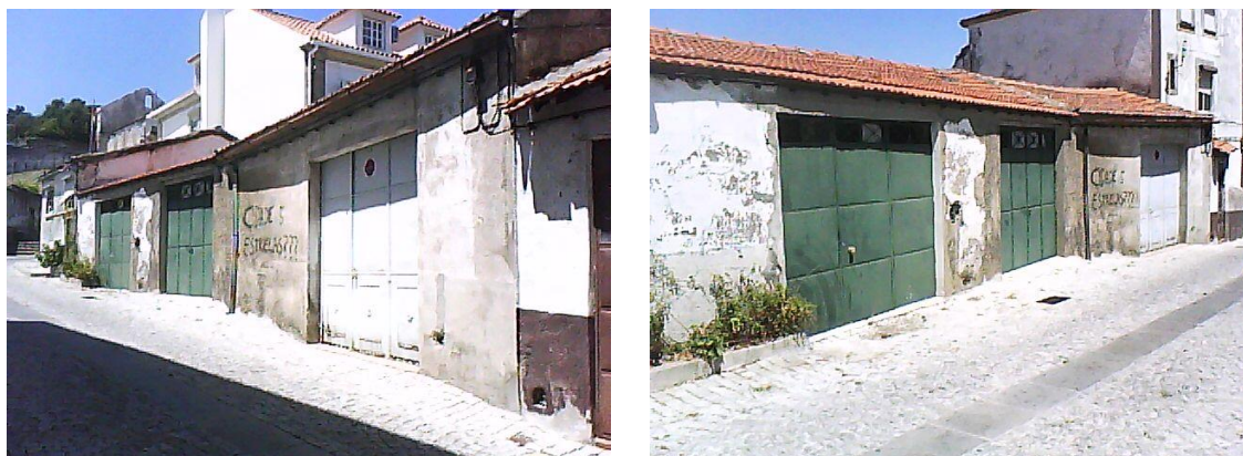
Foto. 15 e 16 - Fachada Principal/Sul.
