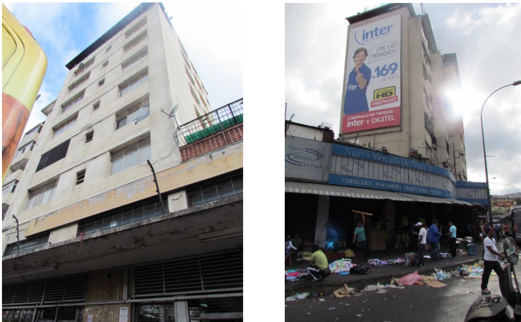
Figuras 51 e 52. Edifício 8 e conjunto dos 3 edifícios. (8,9,10)
