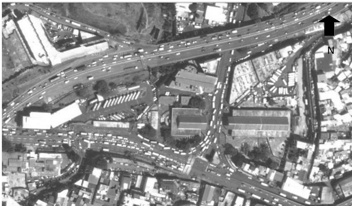
Figura 44. Foto Satélite Largo da Estação do Metro de Petáre
