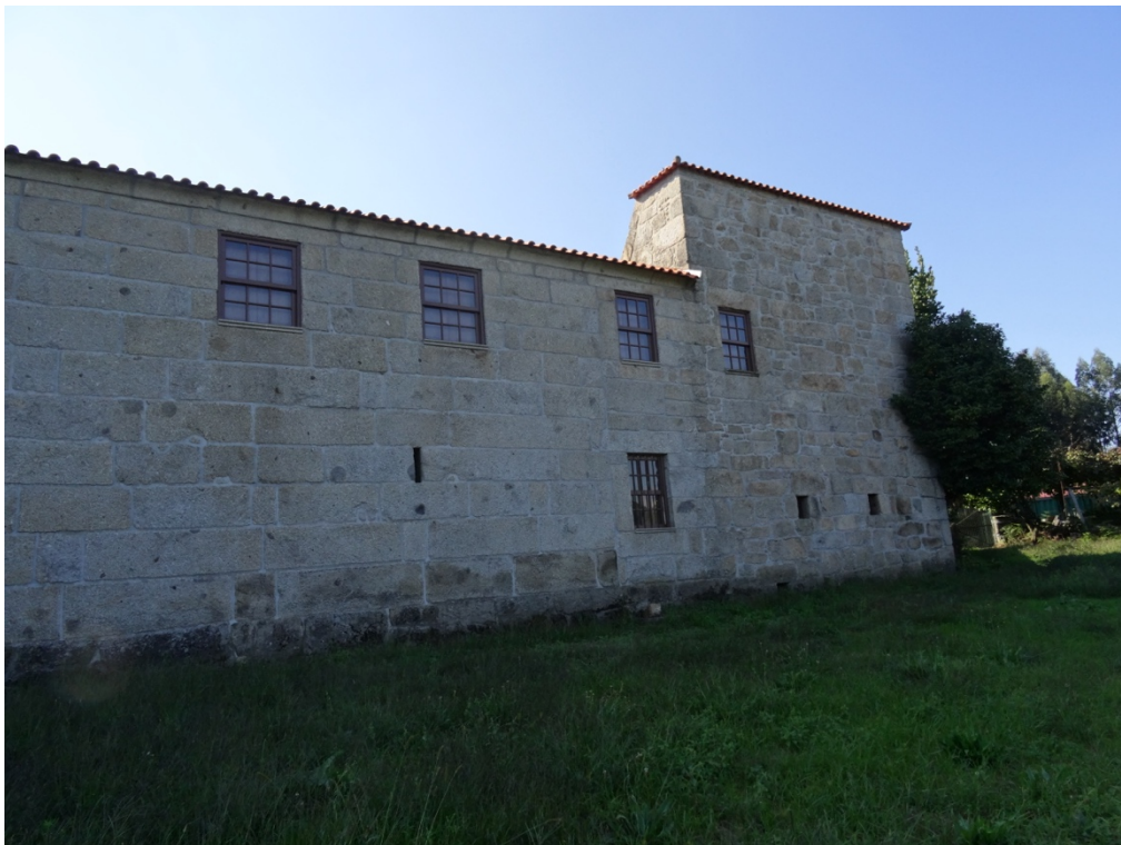
Figura 13 Vista exterior da chaminé. Casa do Bodo.
