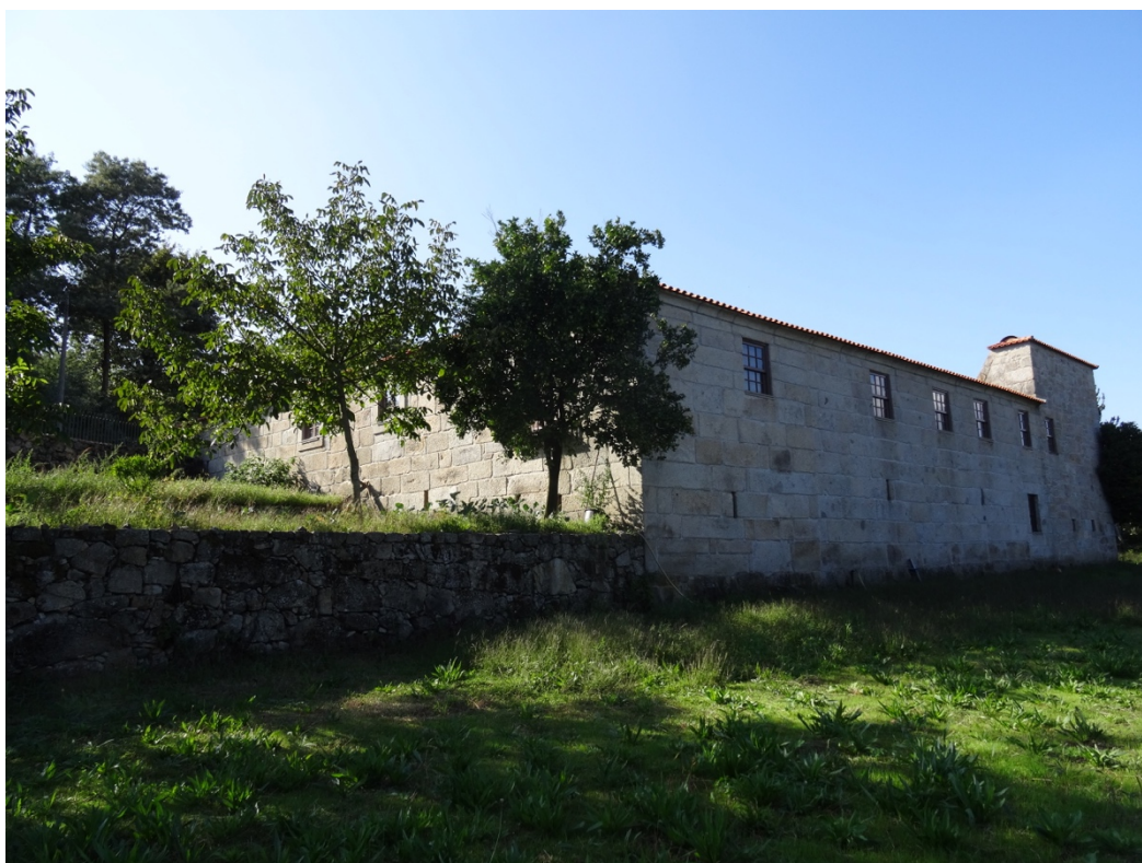
Figura 35 Foto atual do encontro entre as fachadas este e sul.
